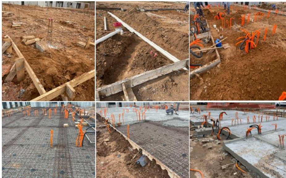
Figura 13 – Execução do Radier
