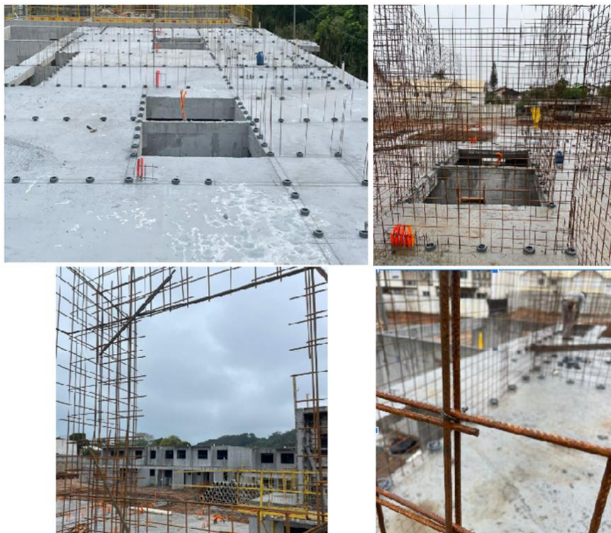
Figura 15 – Montagem da armadura das paredes
