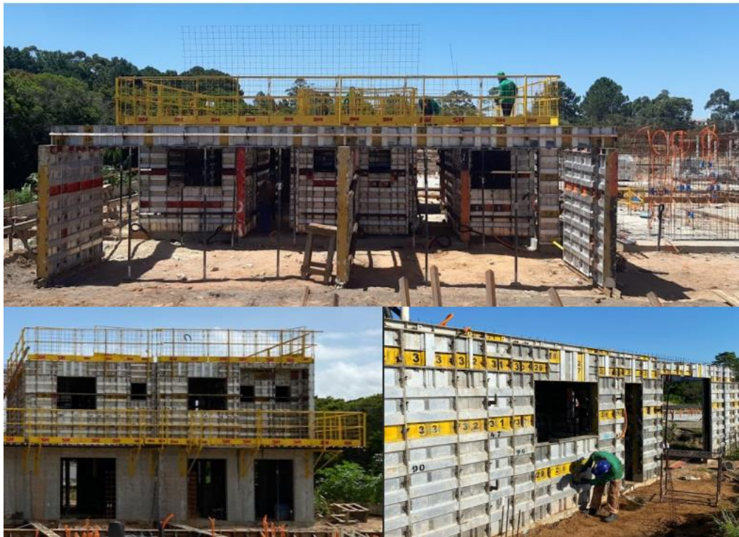
Figura 18 – Montagem das formas das paredes
