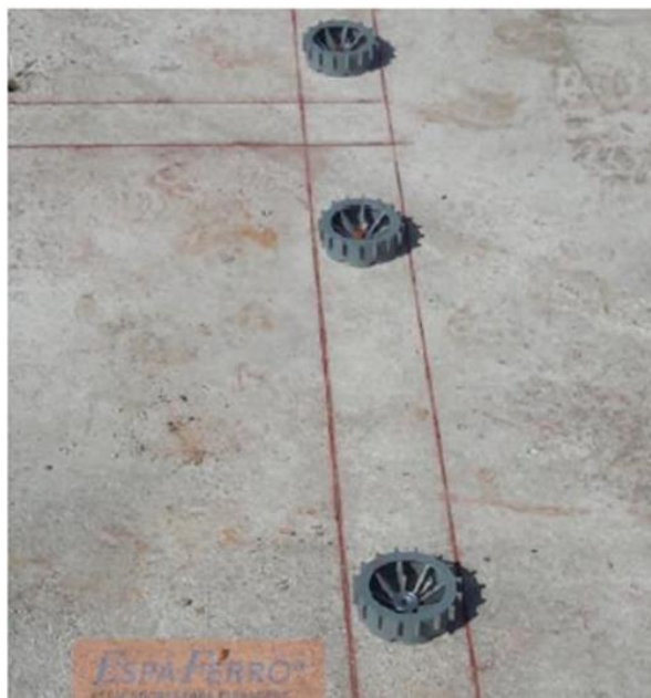
Figura 14 – Marcação e colocação de espaçadores nas lajes e radier
