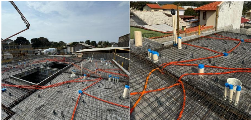
Figura 19 – Montagem da armação, instalações e formas das lajes
