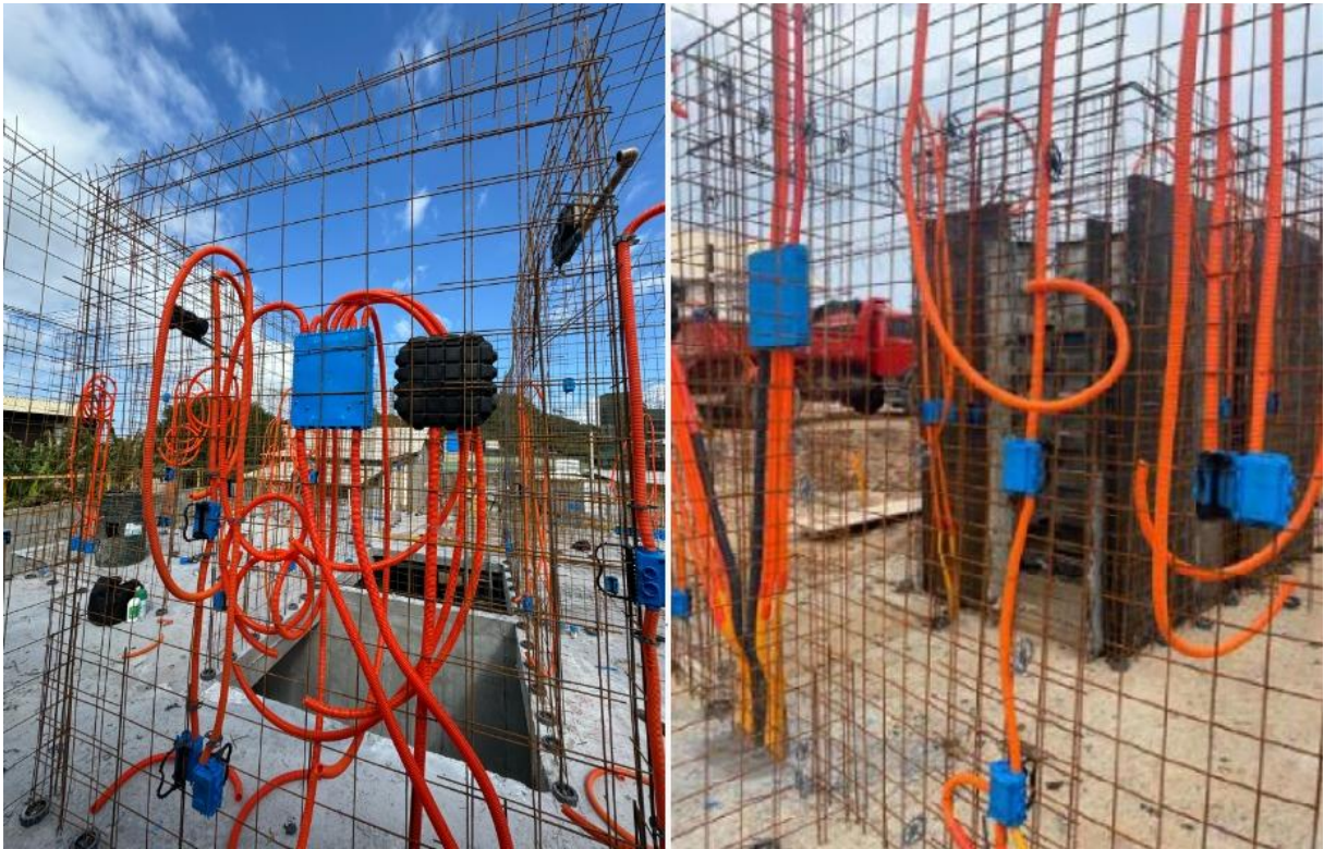
Figura 16 – Montagem da infraestrutura elétrica de telecomunicação das paredes
