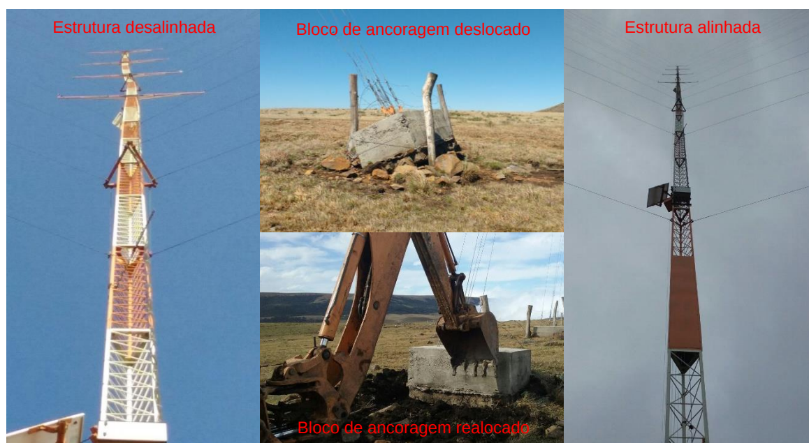
Figura 39 – Manutenção Corretiva realizada na Estrutura da Torre
