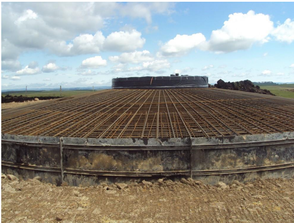
Figura 47 – Base dos Aerogeradores IMPSA
