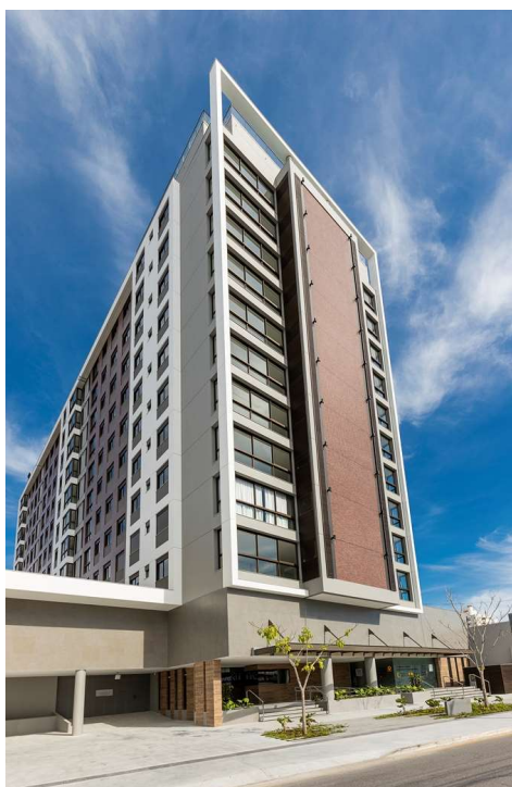
Figura 10 - Fachada Edificação A
