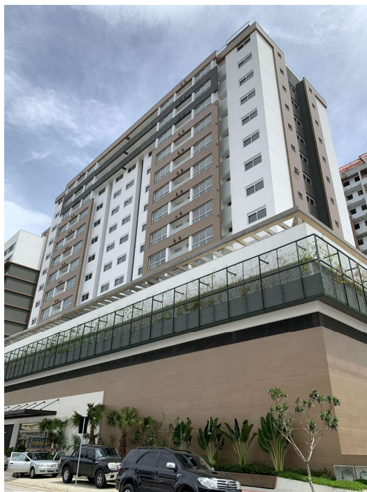
Figura 11 - Fachada Edificação B
