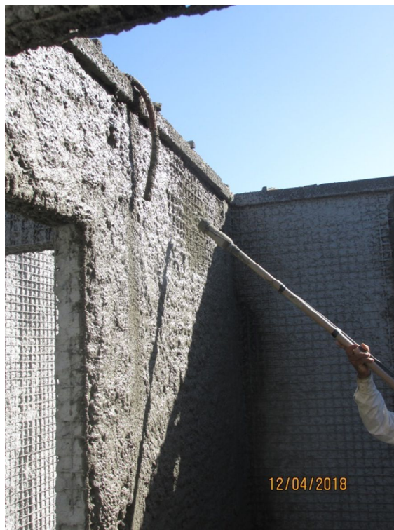
Figura 13 - Aplicação da segunda camada de argamassa estrutural
