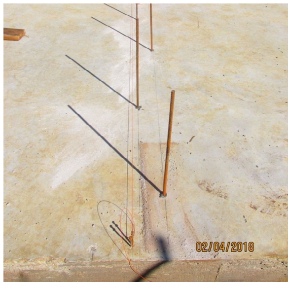
Figura 2 - Fixação das barras de ancoragem
