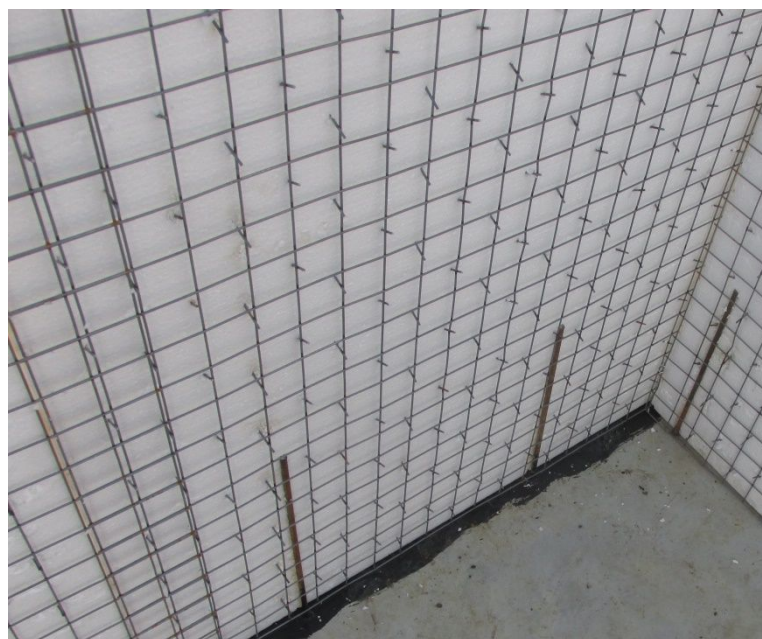
Figura 4 - Posicionamento dos painéis nas barras de arranque
