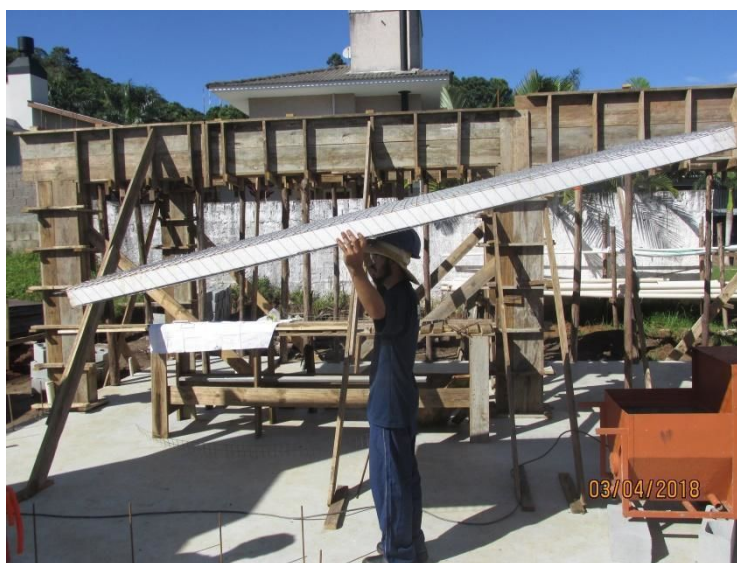
Figura 2- Manuseio dos painéis em EPS
