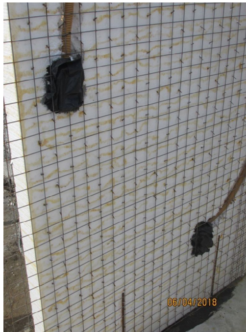
Figura 11- Proteção dos componentes antes da aplicação da argamassa
