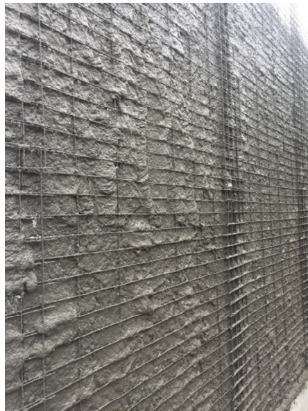
Figura 12 - Aplicação da primeira camada de argamassa estrutural
