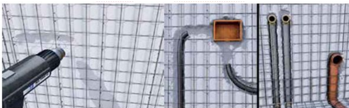
Figura 7 - Execução das instalações elétricas e hidrossanitárias nos painéis de EPS
