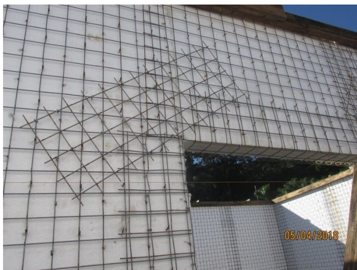
Figura 9 - Instalação dos reforços lisos, com inclinação de 45°, nos cantos de aberturas
