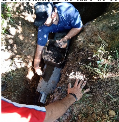
Figura 5. Instalação do tubo de concreto
