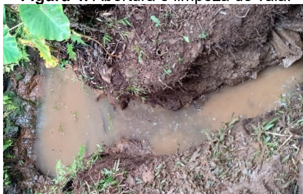
Figura 4. Abertura e limpeza de vala.
