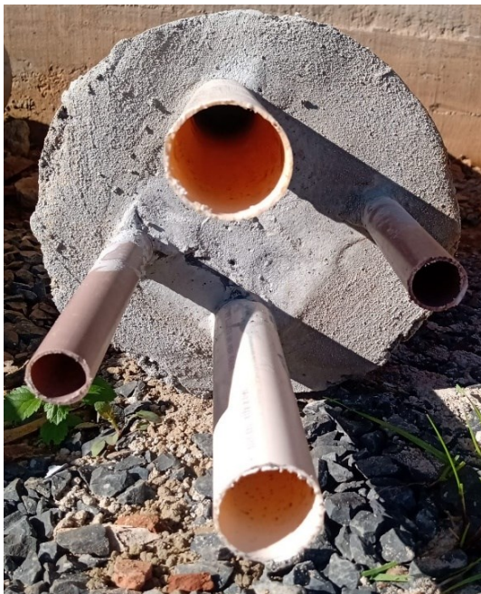
Figura 2. Tubo de concreto com os tubos de PVC instalados.
