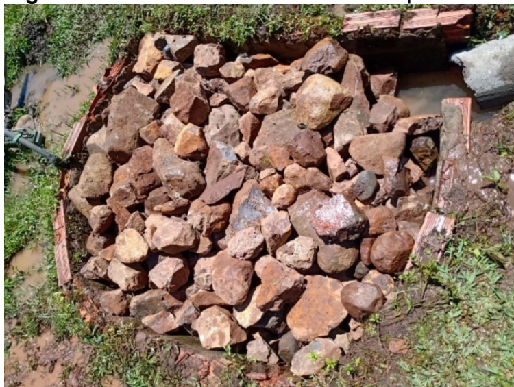
Figura 6. Reservatório da nascente com pedra ferro.
