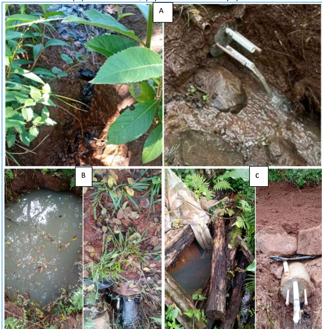
Figura 11. Nascentes: antes (esquerda) e após (esquerda) da proteção da nascente. (A) Nascente 01, (B) Nascente 02 e (C) Nascente 03.
