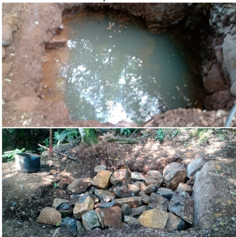
Figura 1. Nascentes com reservatórios grandes, antes e depois da colocação das pedras.
