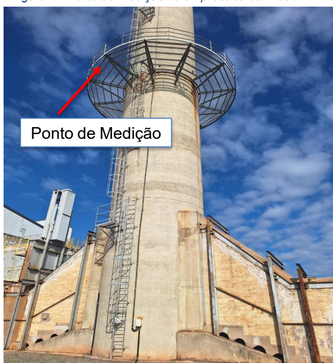
Figura 1 - Ponto de Medição da empresa terceirizada
