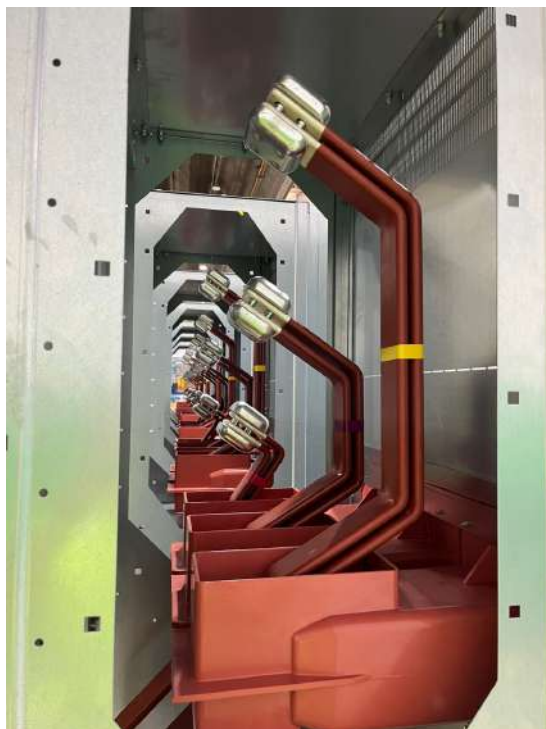
Fig. 1. Vista interna do compartimento de barramento de uma das colunas
