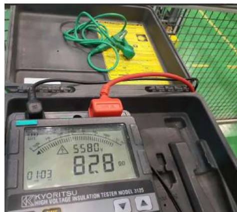
Fig. 5. Medição de resistência de isolamento com megômetro
