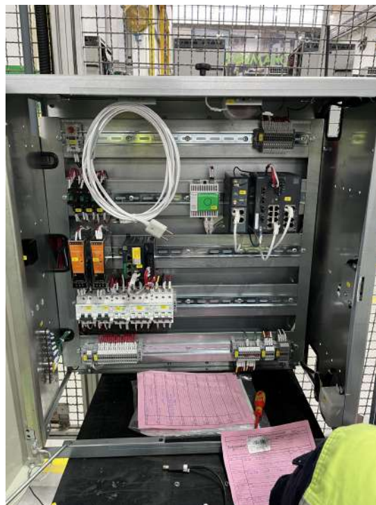
Fig. 4. Montagem da caixa BT
