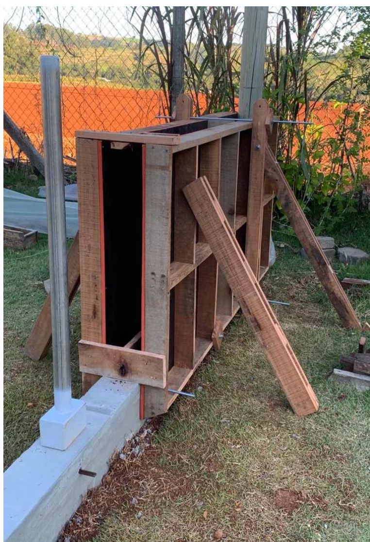
Figura 52: Vista geral da montagem
