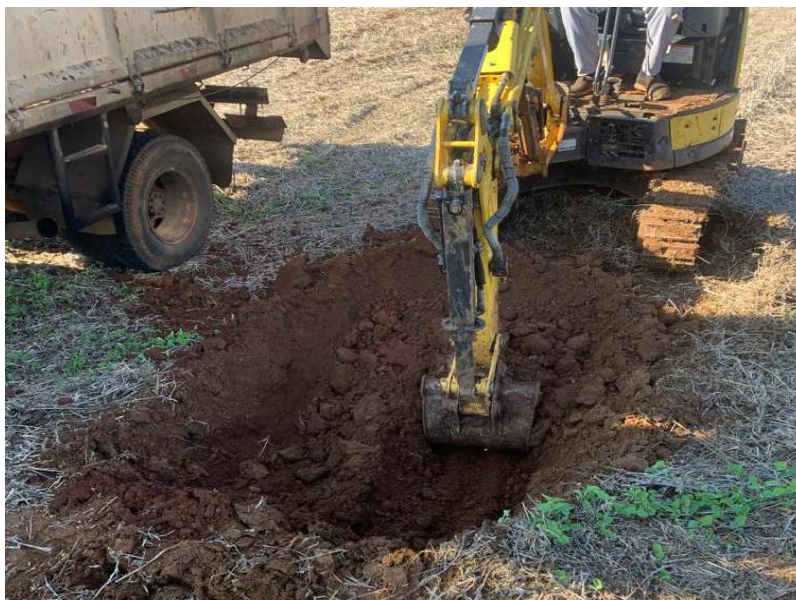
Figura 23: Limpeza do Local da Extração da Terra 1
