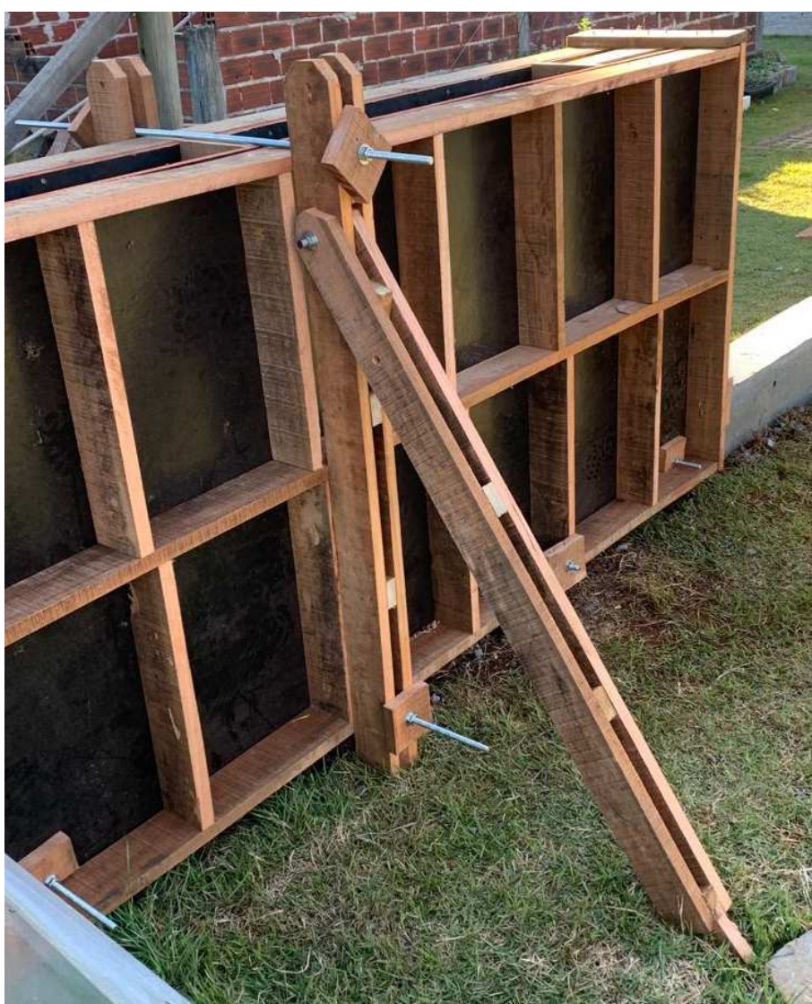
Figura 51: Vista lateral da fôrma montada
