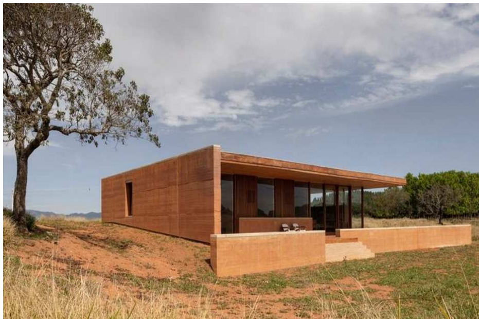
Figura 7: Casa em Cunha – Arquipélago Arquitetos.
