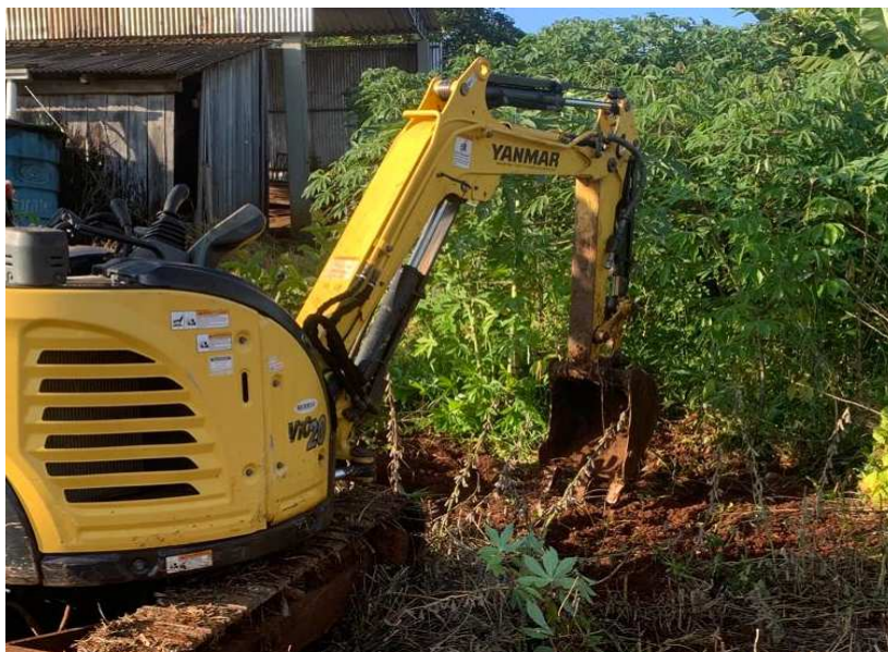
Figura 22: Limpeza do Local da extração da Terra 2
