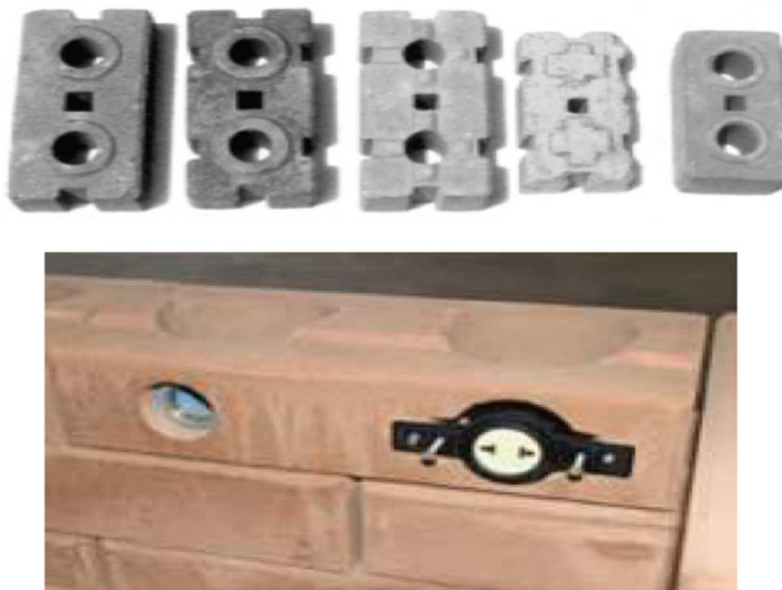
Figura 10: Blocos Perfurados para passagem de utilidades.
