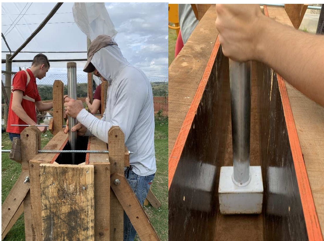
Figura 57: Compactação da camada
