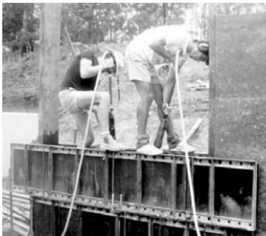
Figura 19: Apiloamento em taipa de pilão
