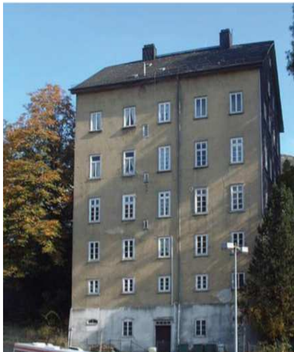
Figura 17: Edifício de 6 andares construído em taipa, Weilburg, Alemanha.
