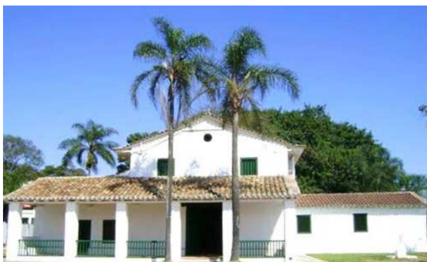
Figura 5: Igreja de São Miguel Arcanjo - S.M. Pta - SP.;
