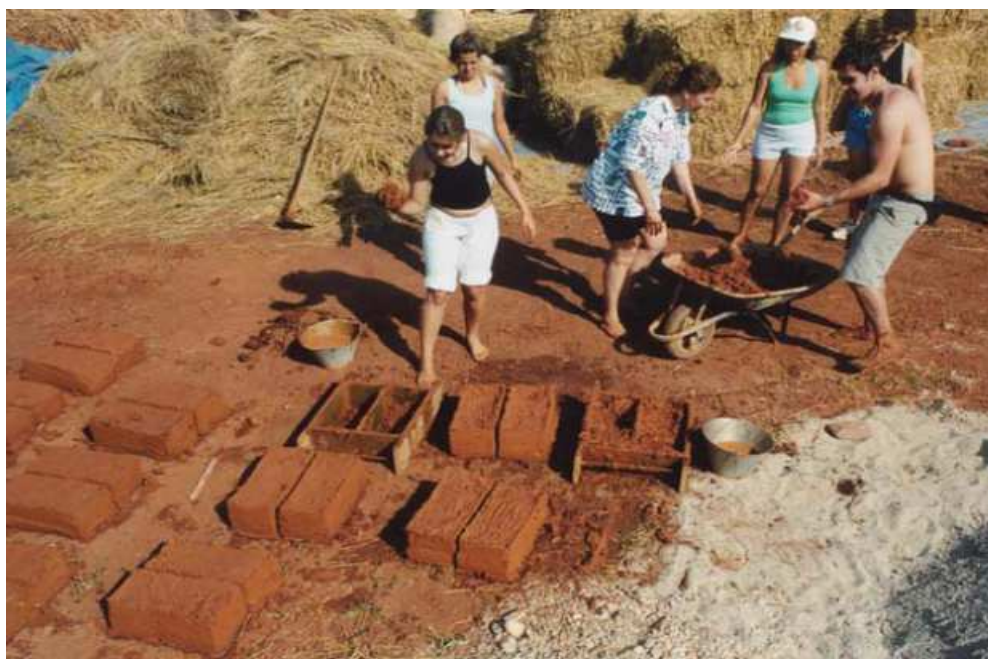
Figura 14: Exemplo de produção dos Blocos de Adobe
