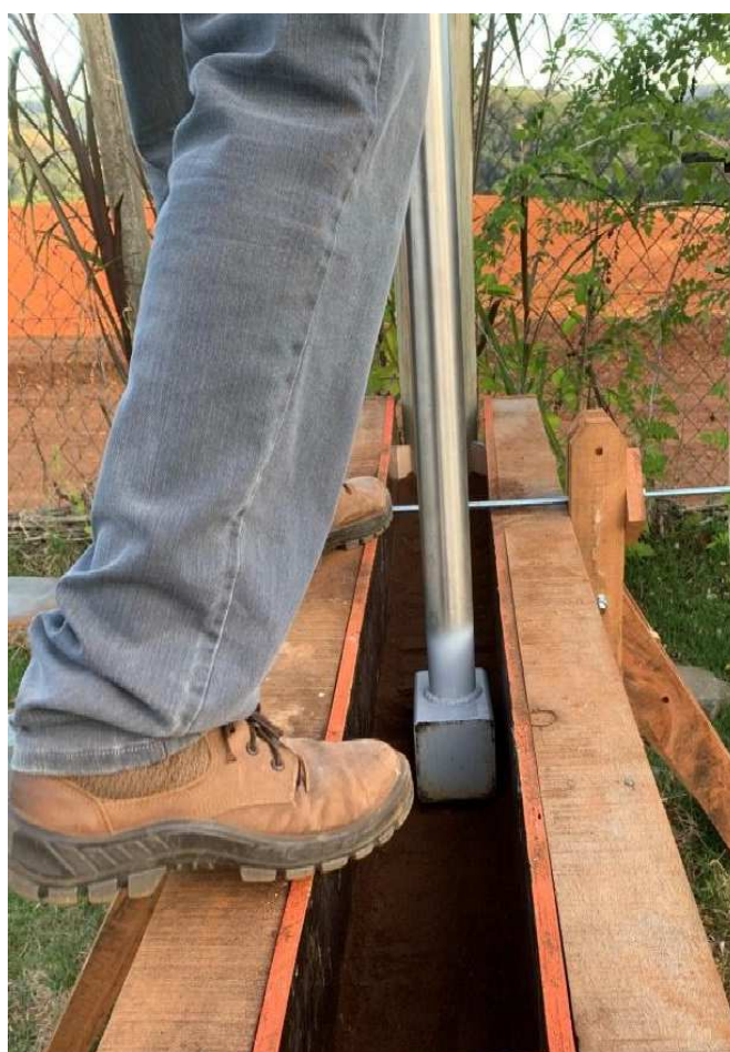
Figura 58: Compactação da última camada de solo-cimento.
