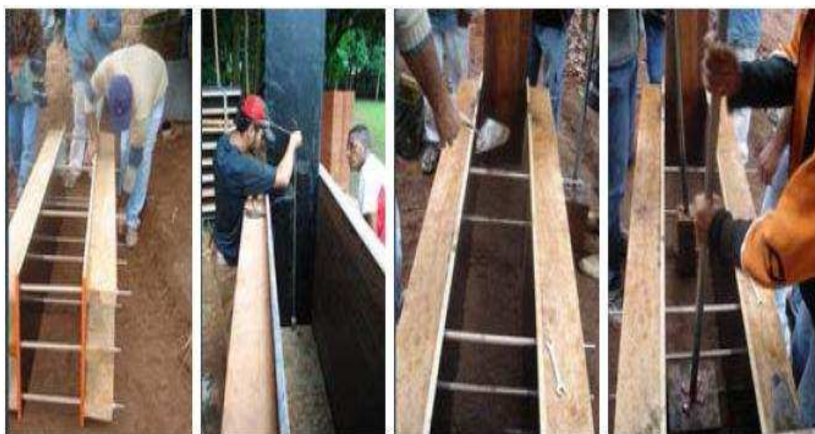
Figura 16: Exemplo de execução de paredes monolíticas em taipa de pilão.
