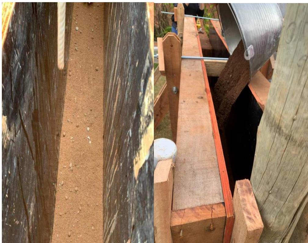
Figura 56: Lançando solo-cimento na fôrma
