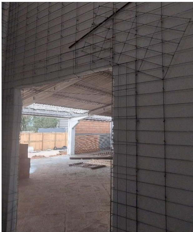
Figura 2.8: Uso de acessórios em U e liso em abertura
