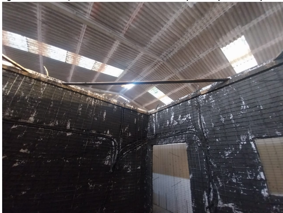
Figura 2.9: Utilização de sarrafos de madeira na parte superior dos painéis
