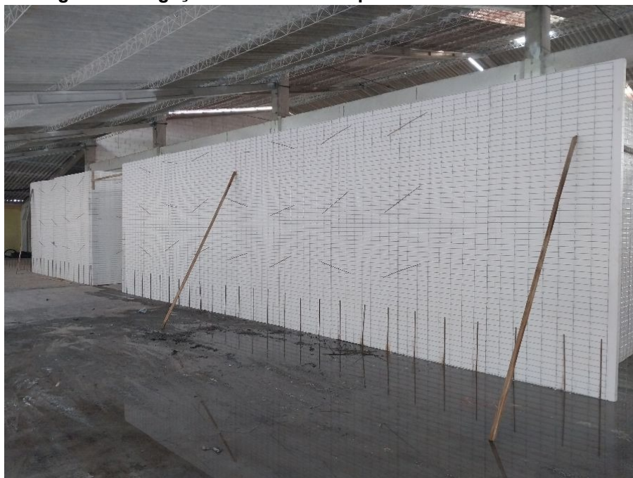
Figura 2.5: Ligação entre o radier e painéis monolíticos de EPS
