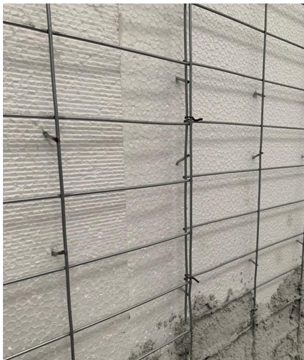
Figura 2.6: Execução da ligação entre painéis monolíticos de EPS com a utilização de arame recozido
