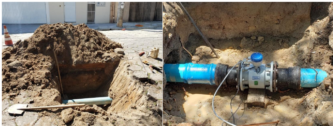
Figura 10 e 11 – Instalação do macromedidor
