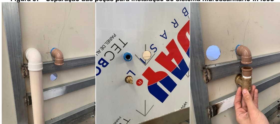
Figura 37 - Separação das peças para instalação do sistema hidrossanitário in loco
