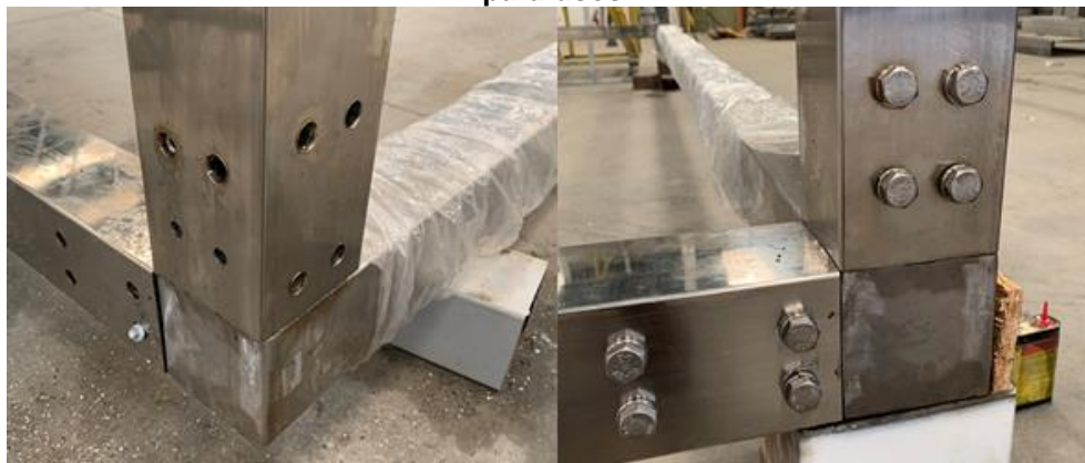
Figura 16 - Furação dos encaixes, vigas inferiores e pilares para possibilitar a fixação com parafusos
