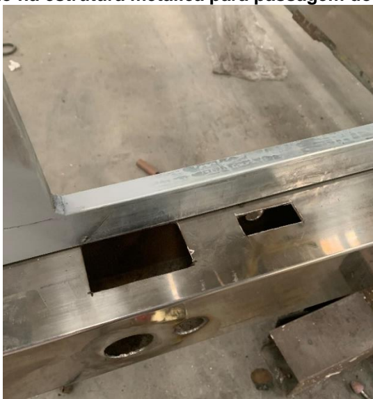
Figura 23 - Furação na estrutura metálica para passagem do sistema hidráulico
