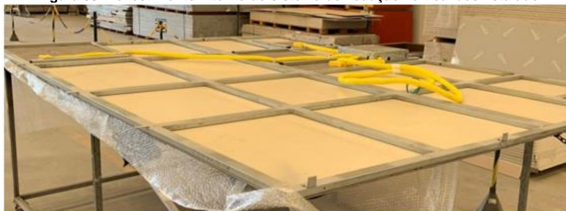
Figura 39—Revestimento interno do sistema de vedação vertical desinstalado
