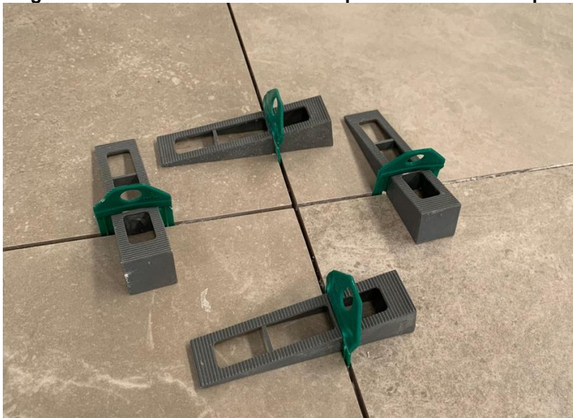
Figura 51–Modelo de cunha utilizada para nivelamento do piso
