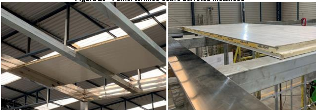
Figura 25 - Painel térmico sobre barrotes metálicos
