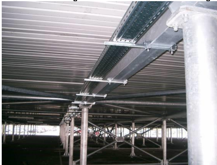
Figura 03 - Estrutura metálica galvanizada no estacionamento Marignane, França
