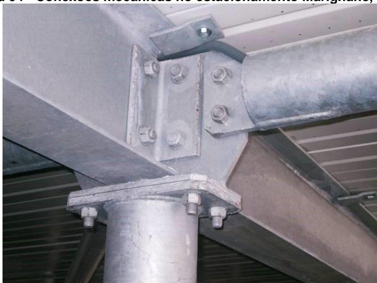
Figura 04 - Conexões mecânicas no estacionamento Marignane, França
