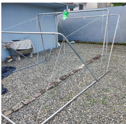
a) Estrutura inicial da garagem.
