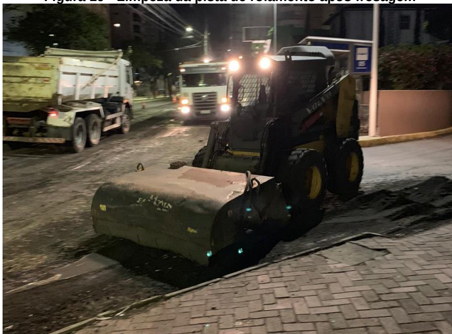
Figura 19 - Limpeza da pista de rolamento após fresagem
