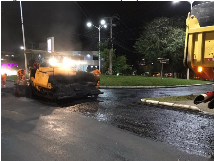
Figura 22 - Acabadora realizando a aplicação da camada asfáltica
