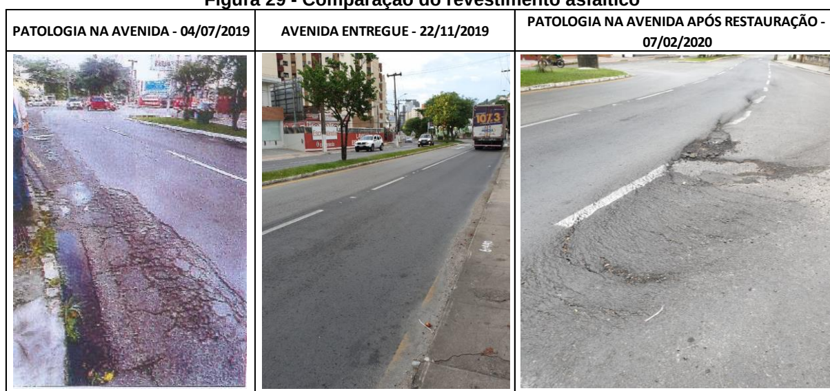
Figura 29 - Comparação do revestimento asfáltico
