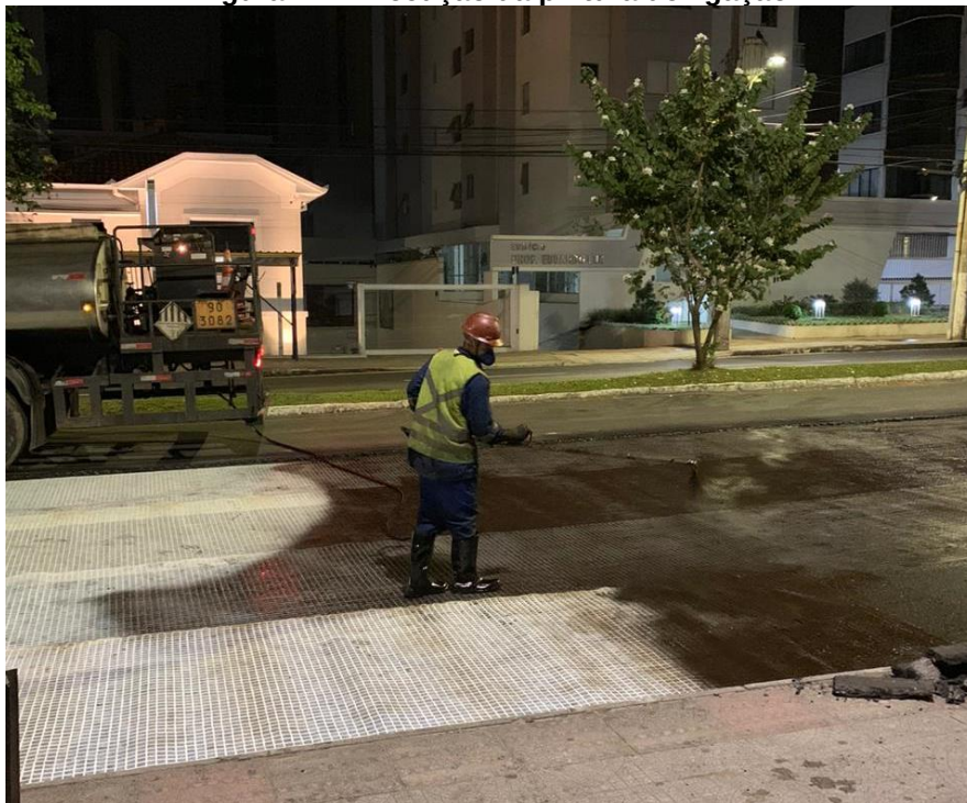
Figura 21 - Execução da pintura de ligação
