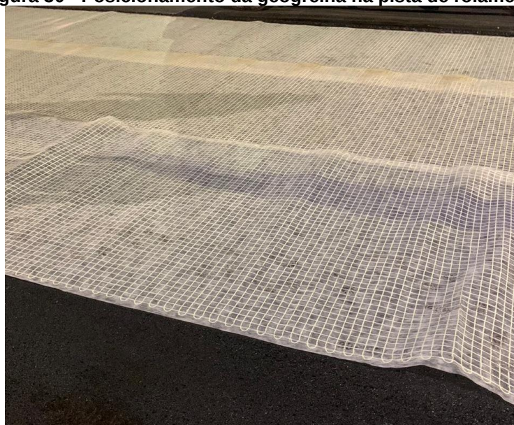
Figura 30 - Posicionamento da geogrelha na pista de rolamento
