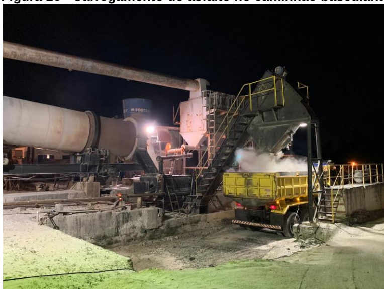
Figura 16 - Carregamento do asfalto no caminhão basculante
