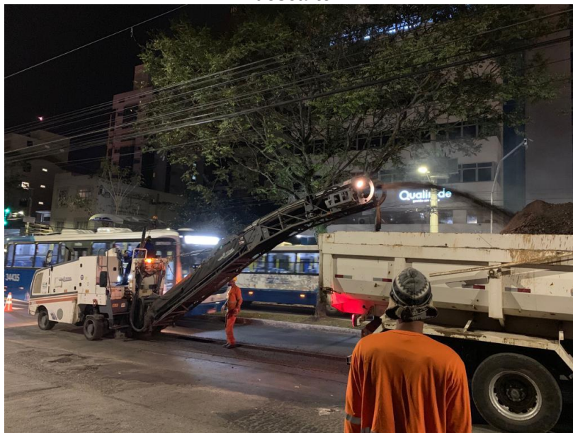
Figura 18 - Fresagem da camada asfáltica sendo depositada no caminhão basculante para descarte
