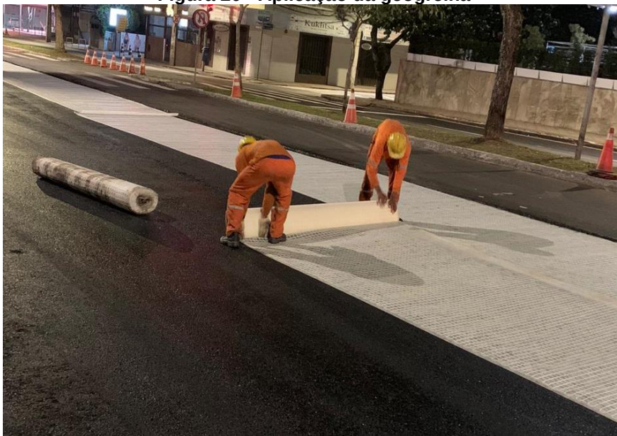
Figura 20 - Aplicação da geogrelha
