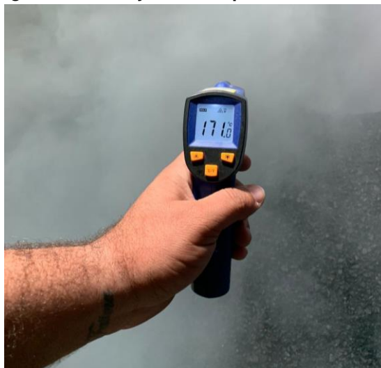
Figura 15 - Medição da temperatura do asfalto
