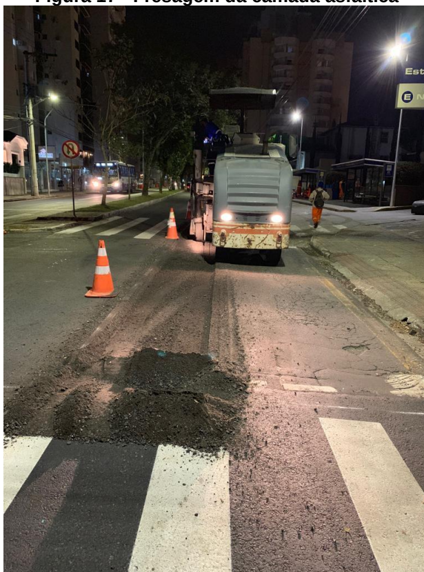
Figura 17 - Fresagem da camada asfáltica
