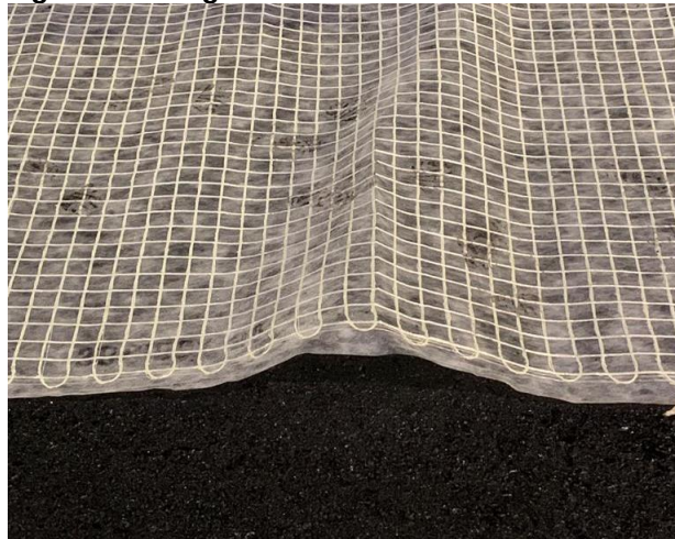
Figura 7 - Geogrelha utilizada na obra em análise
