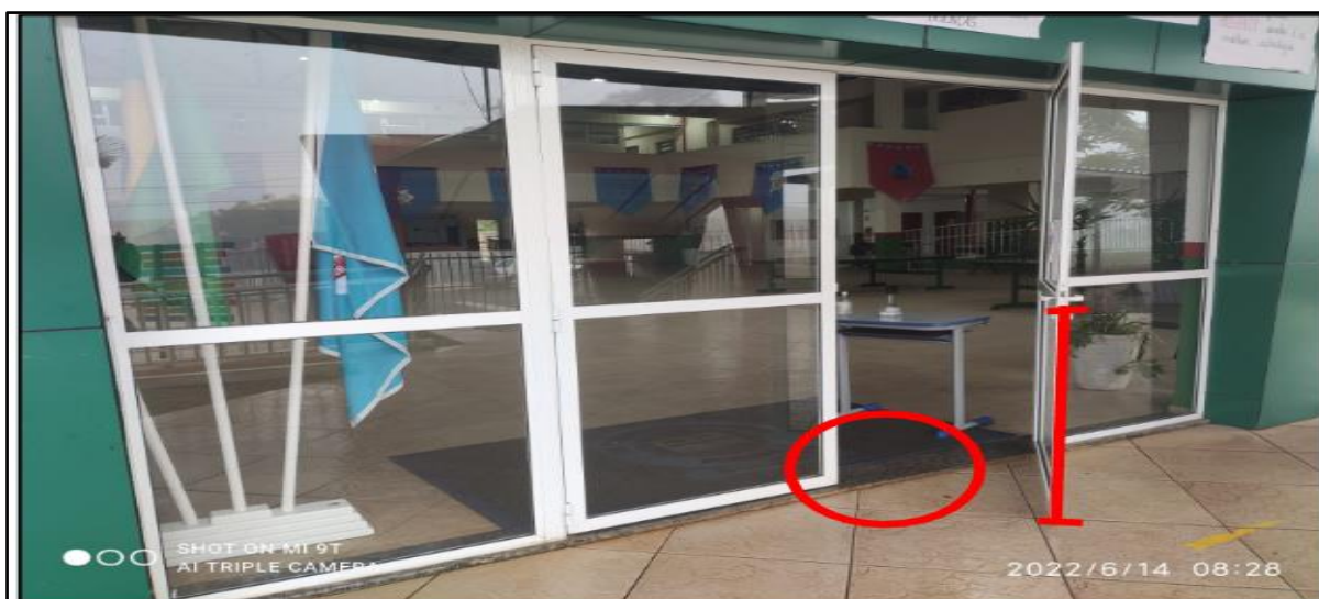
Figura 22 - Acesso interno à edificação. E.E.B. Felisberto de Carvalho Palmitos - SC.
