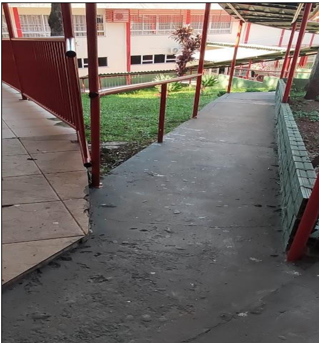
Figura 42 - Interseção entre a passarela e a rampa na área de circulação.
