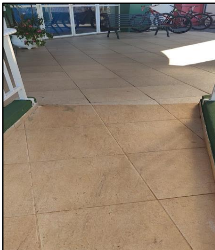
Figura 25 - Acesso principal - Fim da rampa. E.E.B. Felisberto de Carvalho Palmitos - SC.
