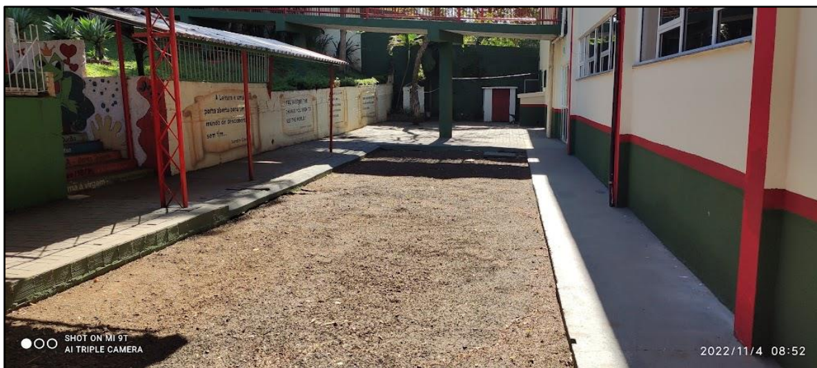
Figura 29 - Área localizada à direita dos fundos do primeiro bloco de salas de aula.
