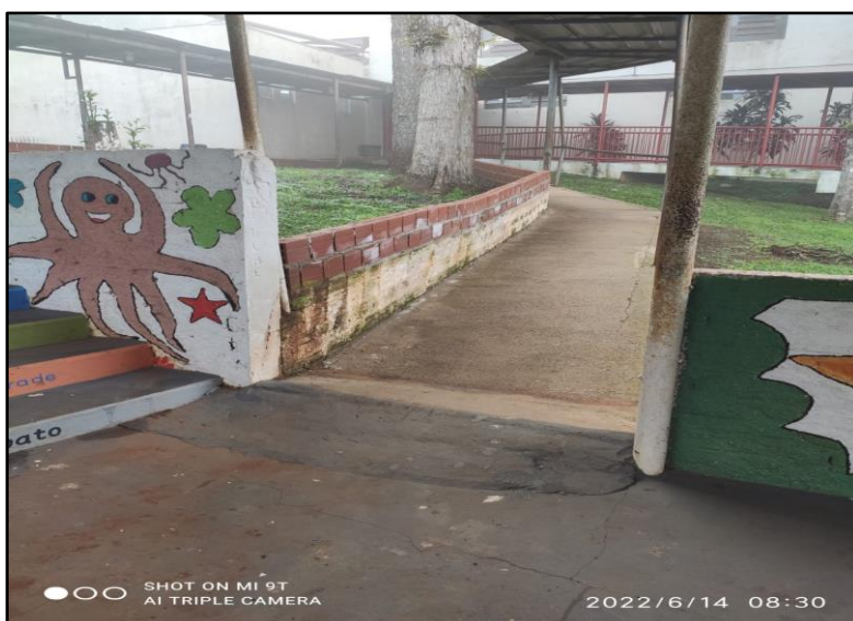
Figura 33- Patamar de acesso a bloco de salas de aula.
