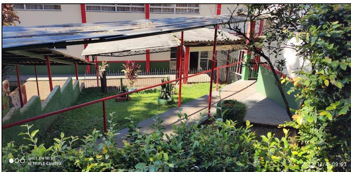
Figura 35 - Rampa de acesso a bloco de salas de aula.
