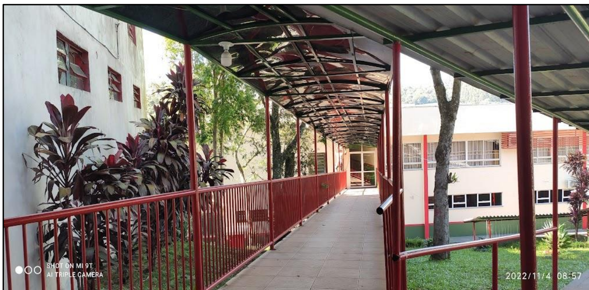
Figura 39 - Passarela de acesso ao primeiro bloco de salas de aula-materiais construtivos.
