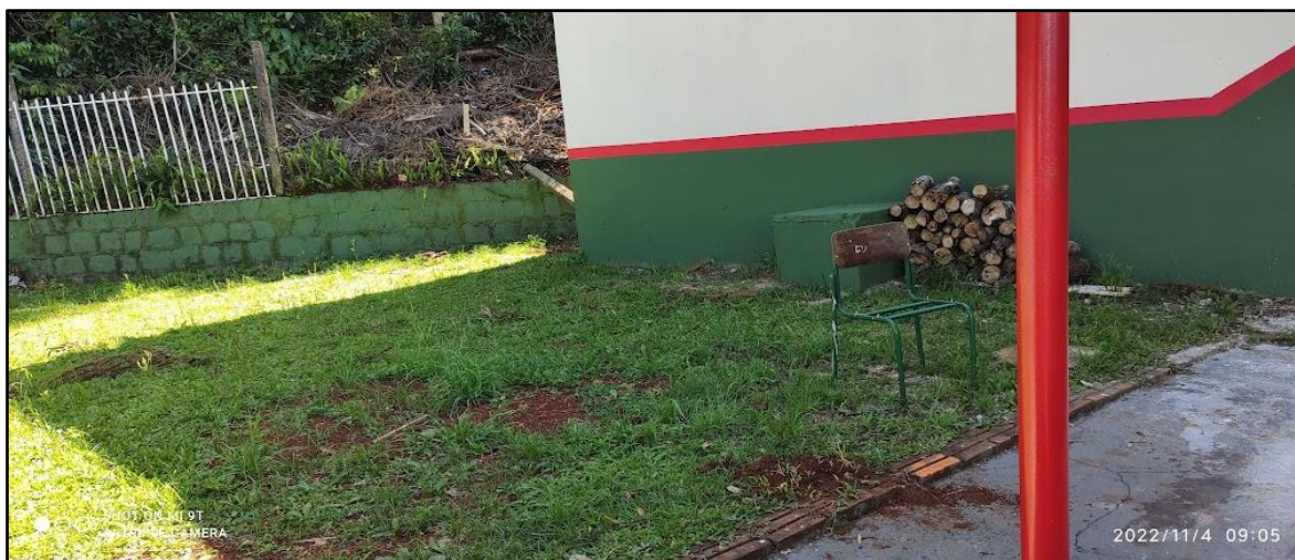
Figura 43 - Área lateral do acesso ao ginásio de esportes com entulhos. Talude aos fundos.
