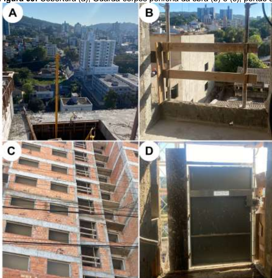
Figura 09: Cobertura (a), Guarda-corpos periferia da obra (b) e (c), portão elevador cremalheira (d).
