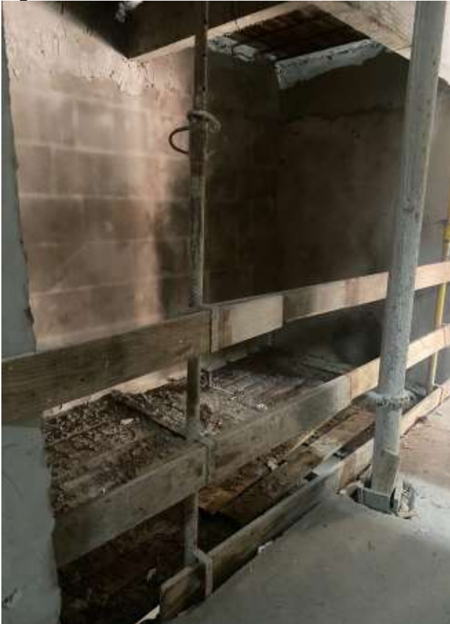
Figura 08: Fosso do elevador.
