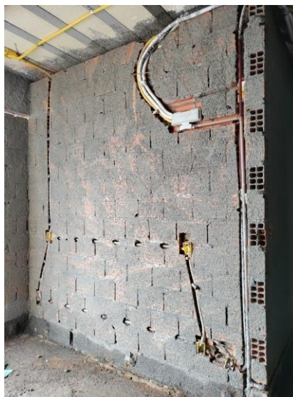
Figura 16: Local do recorte da alvenaria
