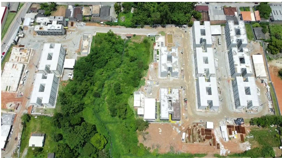
Figura 11 - Empreendimento em construção
