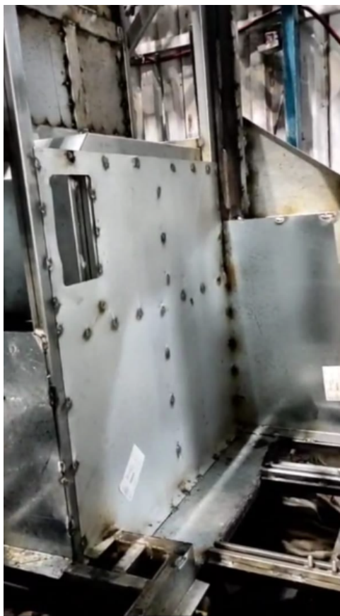
Figura 2 – Uniões entre chapa e perfis pelo processo de soldagem GMAW.
