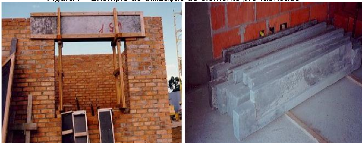
Figura 7 - Exemplo de utilização de elemento pré-fabricado
