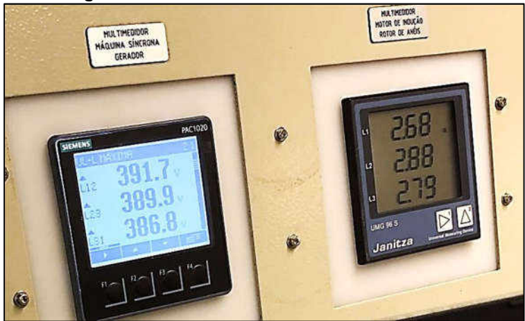
Figura 20 - Novos multimedidores instalados
