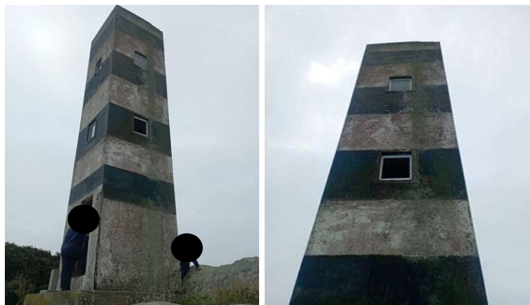
Figura 17 - Vista geral da estrutura de concreto armado localizada na Ilha de Galé, Bombinhas/SC
