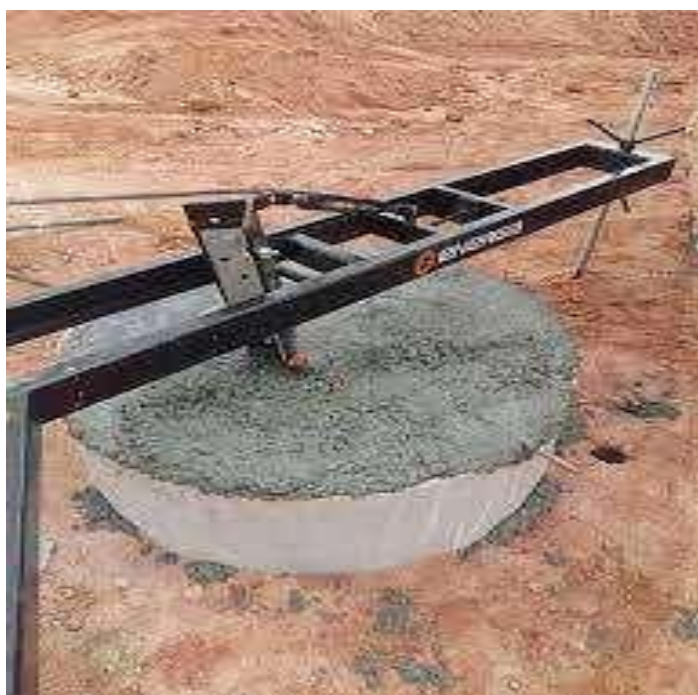
Figura 16 - Nivelamento do Stub na fundação
