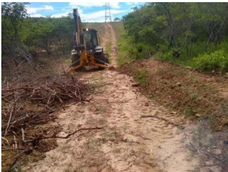
Figura 15 - Limpeza de faixa com retroescavadeira
