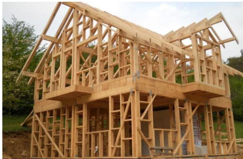
Figura 2 - Ossatura em wood frame
