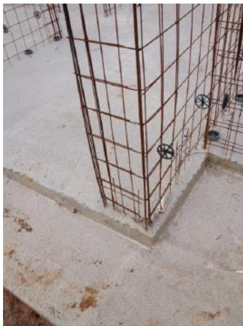
Figura 11 – Reforços nos encontros de paredes e fixação dos espaçadores
