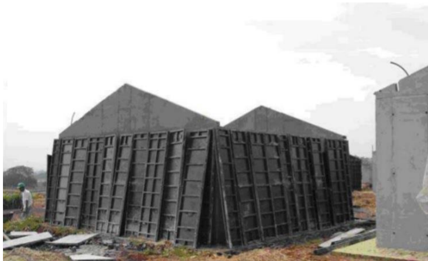
Figura 14 – Desforma
