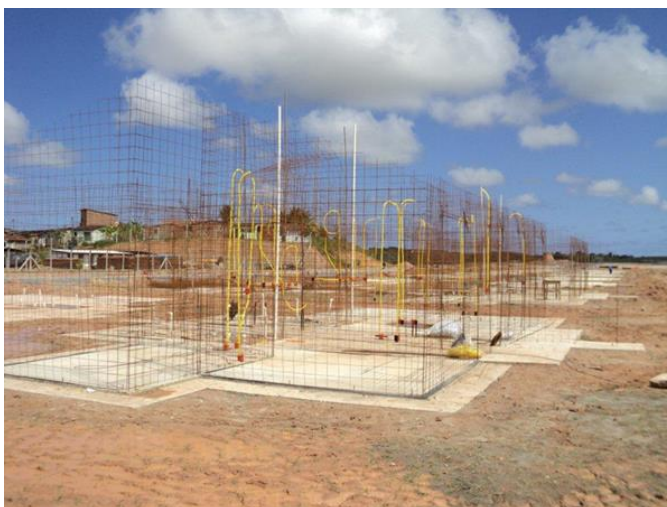
Figura 7 – Armação em tela soldada - Condomínio Residencial em Ipojuca/PE
