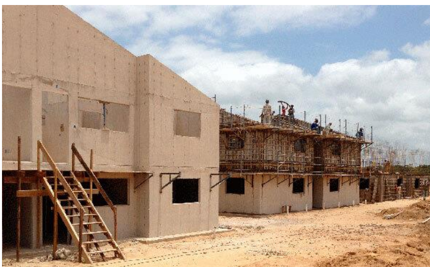
Figura 1 - Sistema Gethal: Paredes em Concreto Celular moldadas in loco
