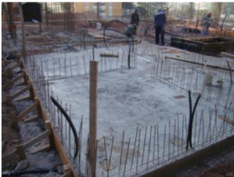
Figura 10 – Fundação com arranques e localização das instalações sanitárias
