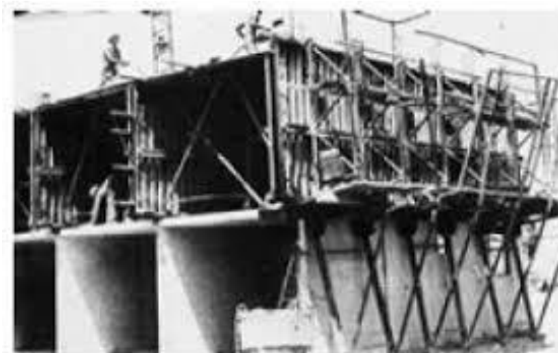
Figura 2 - Sistema Outinord - Fôrmas metálicas tipo túnel
