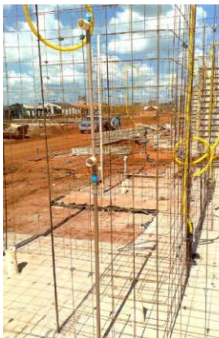
Figura 12 – Fixação das instalações hidráulicas
