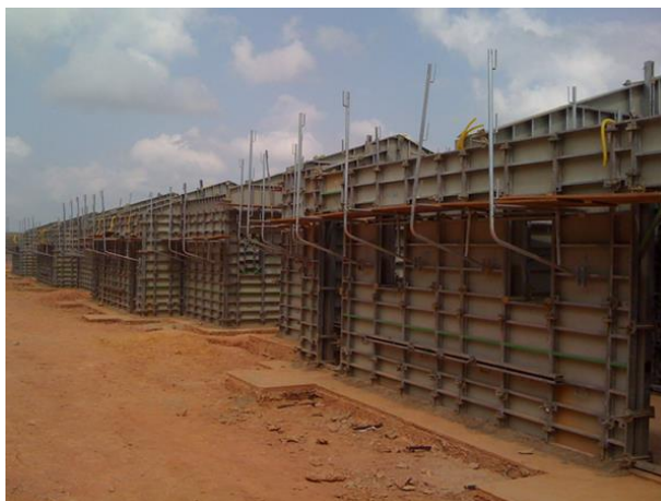
Figura 5 – Fôrmas metálicas
