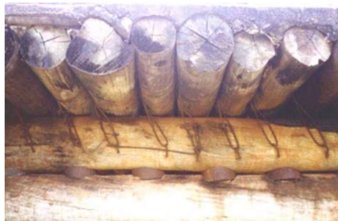
Figura 6 – Ponte em viga com peça roliça composta
