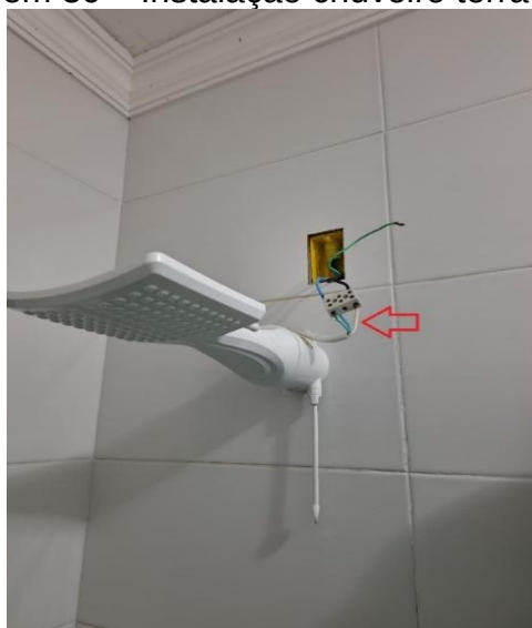
Imagem 36 – Instalação chuveiro terra + neutro.
