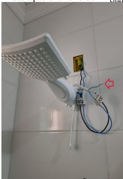
Imagem 35 – Instalação chuveiro com T_{\text{chuveiro}} flutuante.
