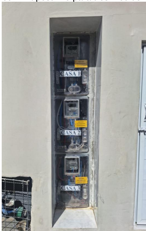
Imagem 39 – Kit postinho para três medidores.
