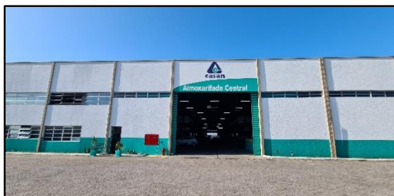
Figura 3 - Fachada do Almojarifado
