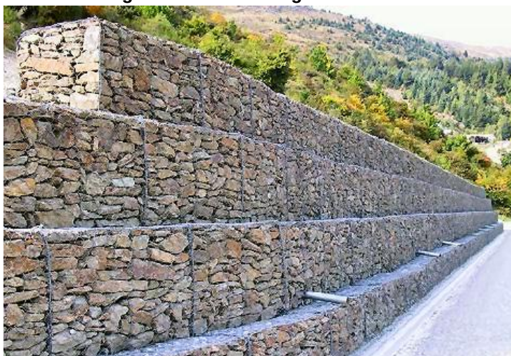
Figura 2.7 – Muro de gabião
