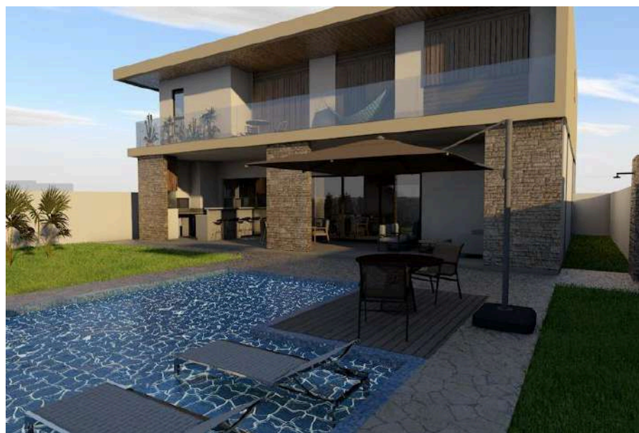
Figura 4 – Vista do empreendimento de alto (Casa 1)
