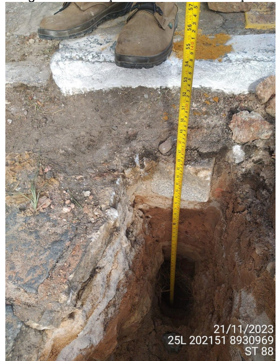
Figura 11: Medição da altura da tubulação.
