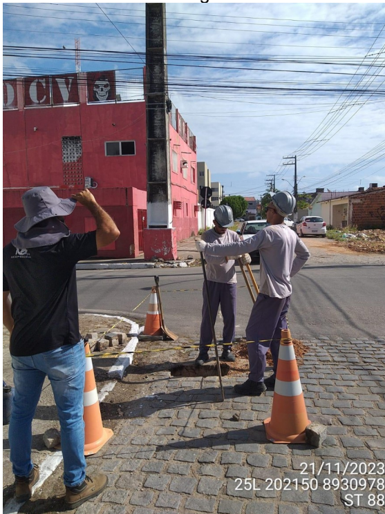
Figura 10: Processo de escavação para sondagem.
