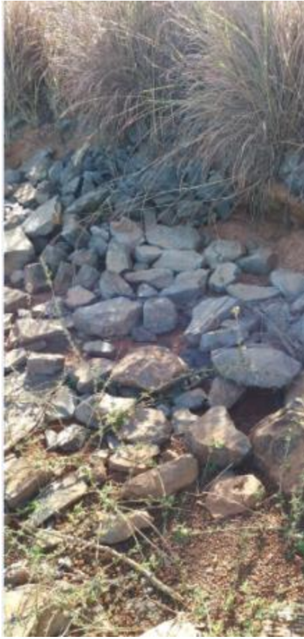
Figura 13 - Talude de montante da barragem de terra com falhas do “rip-rap”.
