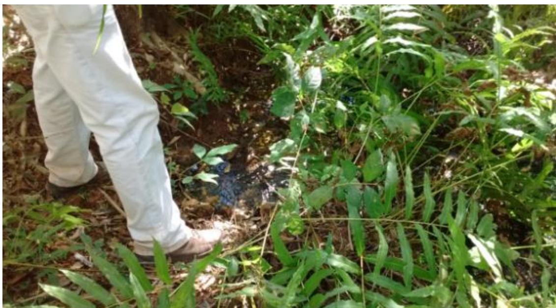
Figura 21 - Surgência de água junto à antiga calha do rio.
