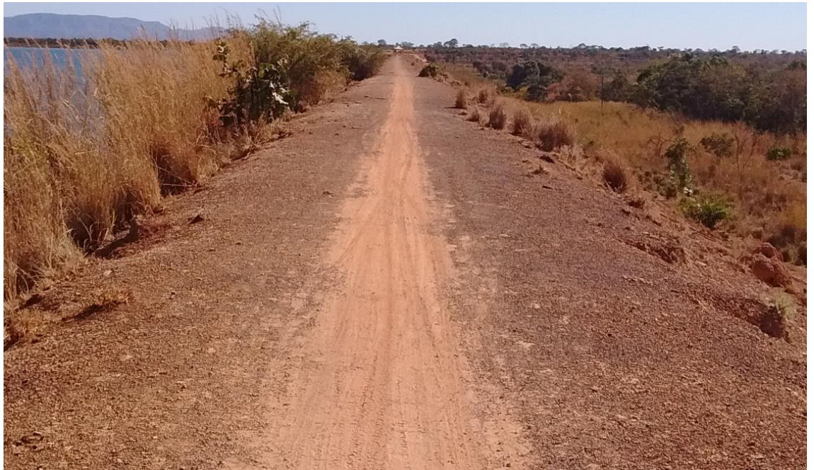
Figura 19 - Crista da barragem de terra sem sistema de drenagem superficial.
