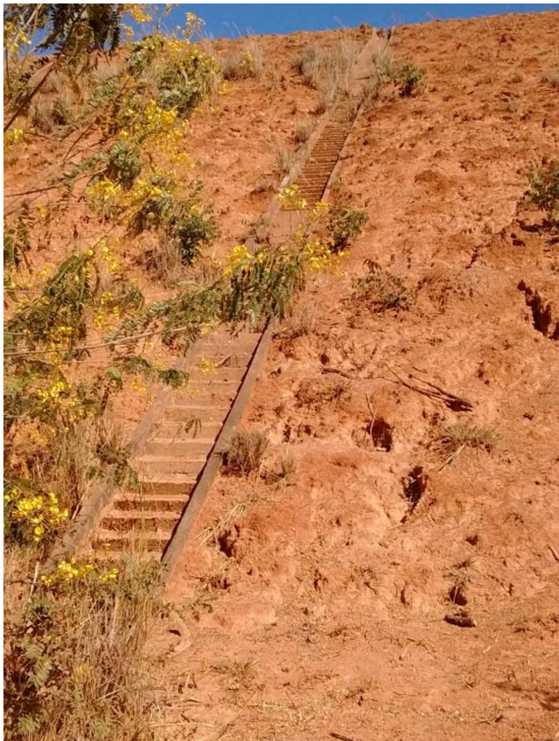
Figura 20 - Descida em escada com degraus apresentando assoreamento.
