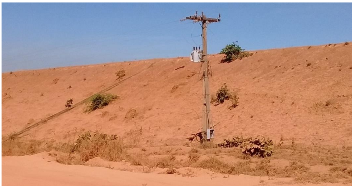
Figura 8 - Talude de jusante com a incidência de arbustos.
