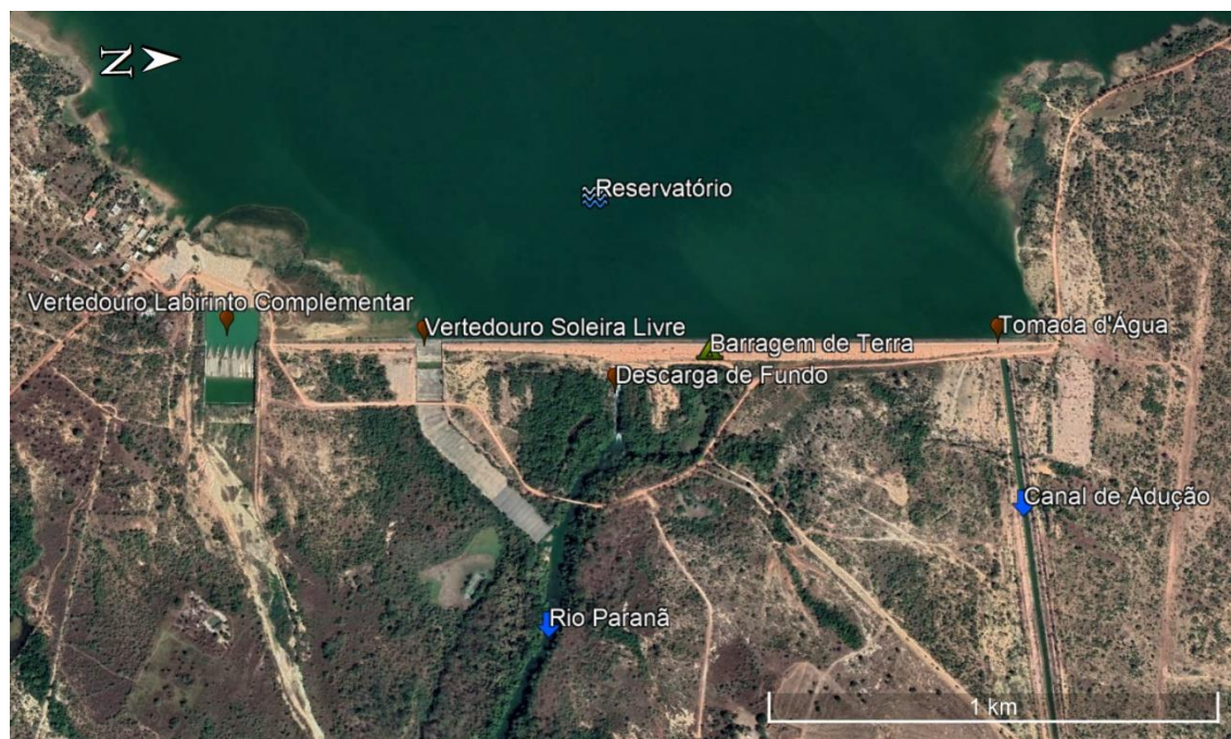
Figura 3 - Indicação das Estruturas Principais da Barragem.
