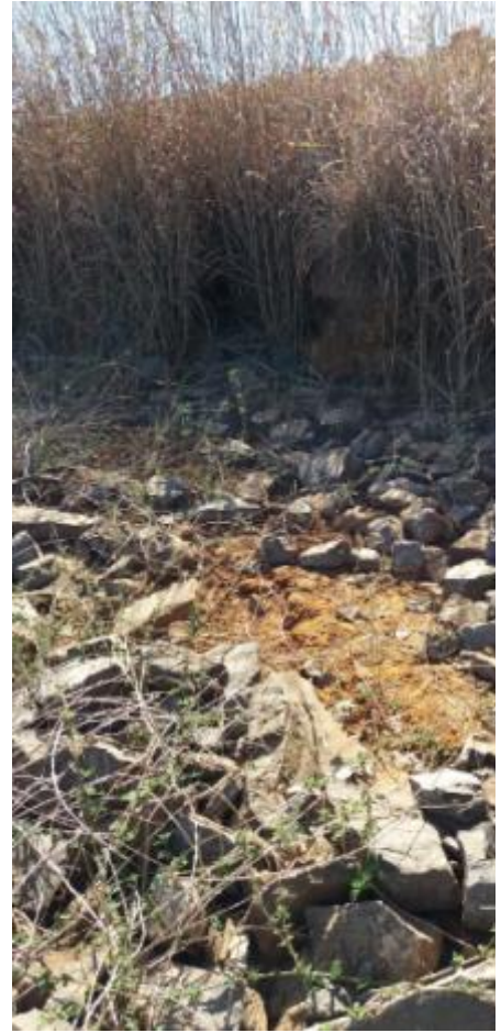
Figura 13 - Talude de montante da barragem de terra com falhas do “rip-rap”.
