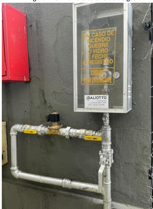
Figura 113 - Válvula solenóide de gás
