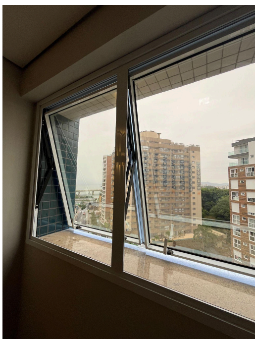
Figura 127 - Abertura esquadrias corredores
