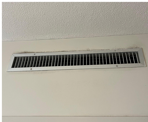
Figura 116 - Grelha de renovação de ar
