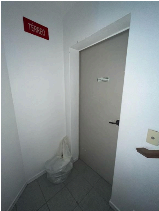
Figura 7 – Porta de acesso a câmara (Garagem G1)
