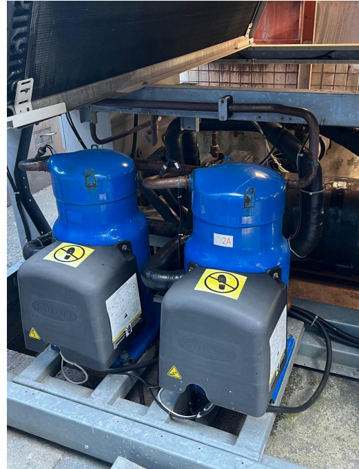
Figura 100 - Compressor chiller
