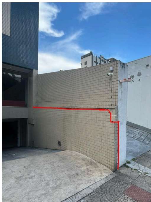
Figura 138 - Possível criação de junta de movimentação do muro
