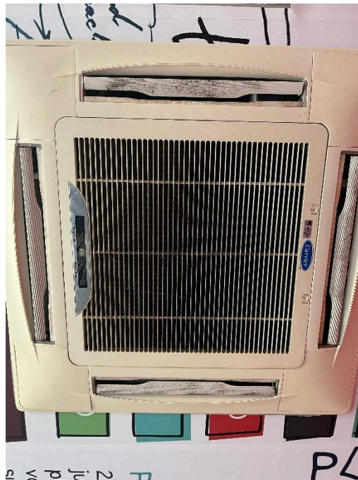
Figura 120 – Acúmulo de sujeira na máquina
