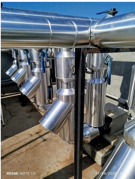
Figura 29 - Troca de isolamento de entrada
