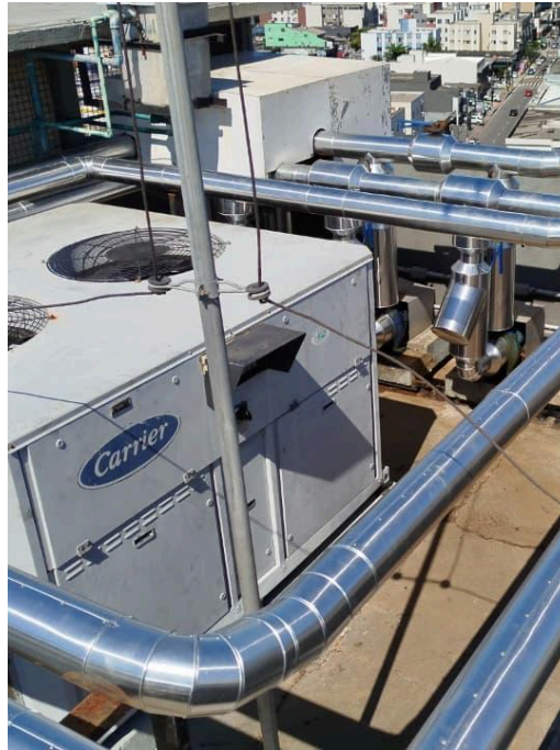
Figura 30 - Troca de isolamento de entrada
