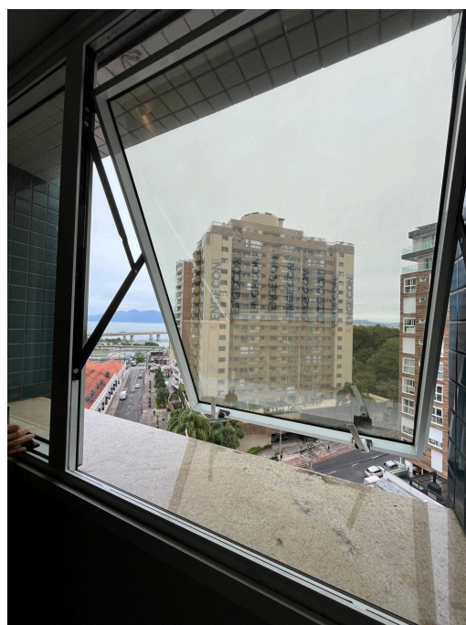
Figura 129 - Abertura esquadrias corredores
