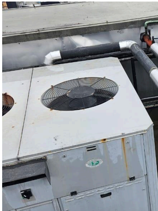
Figura 30 - Troca de isolamento de entrada
