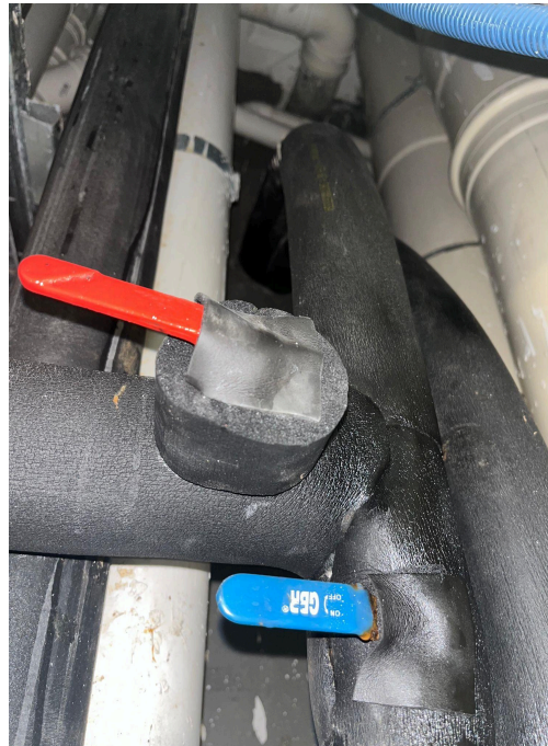
Figura 32 - Novo isolamento de água gelada
