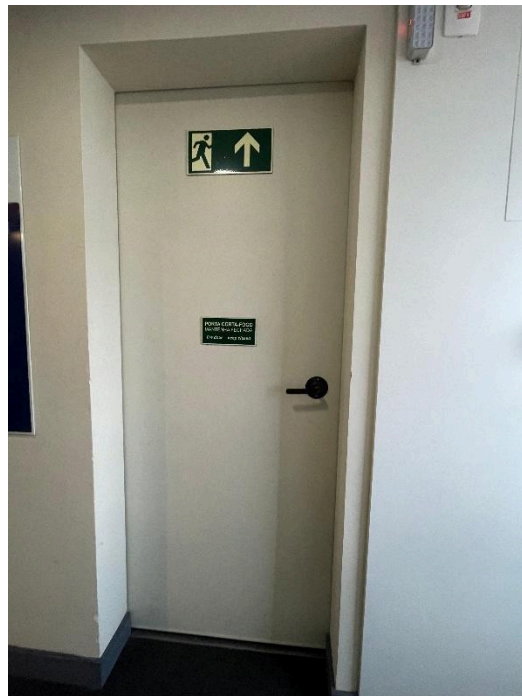
Figura 10 - Porta acesso a câmara (2° Pav.)
