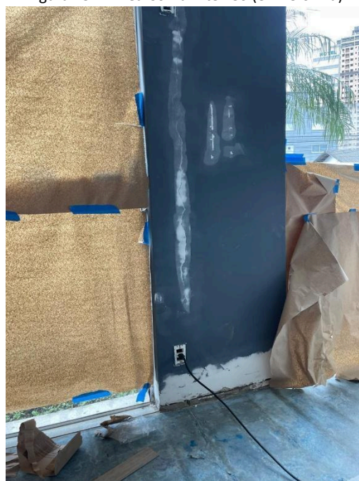
Figura 134 - Área Comum térreo (em reforma)
