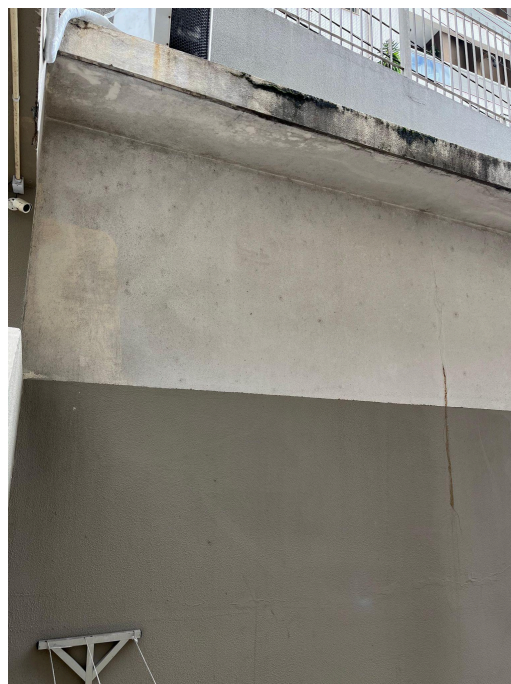
Figura 132 - Muro área dos fundos do hotel
