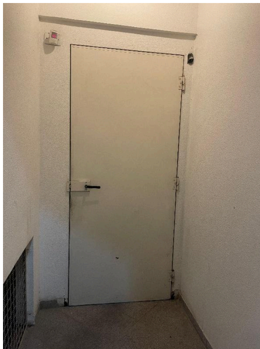
Figura 06 - Porta de acesso a escadaria (Garagem G1)
