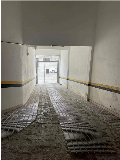
Figura 146 - Acesso Lateral G1 - Torre O1.
