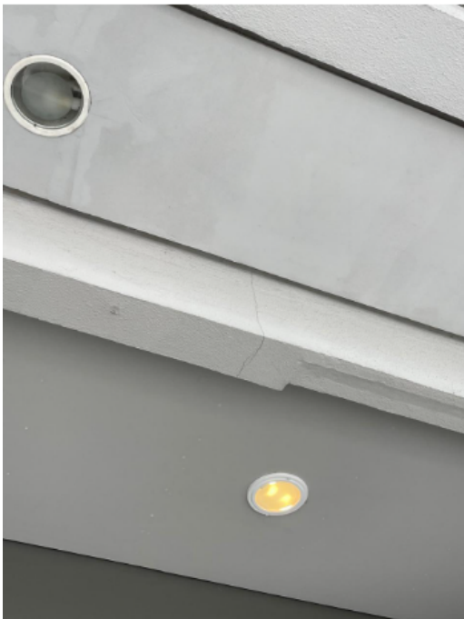
Figura 127 - Marquise do Térreo.
