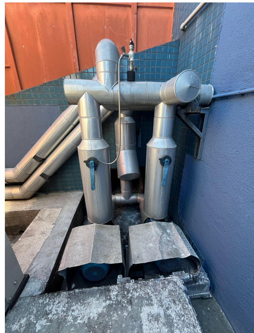
Figura 102 - Motobomba chiller
