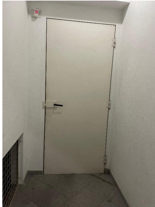
Figura 08 - Porta de acesso a escadaria (Garagem G2)
