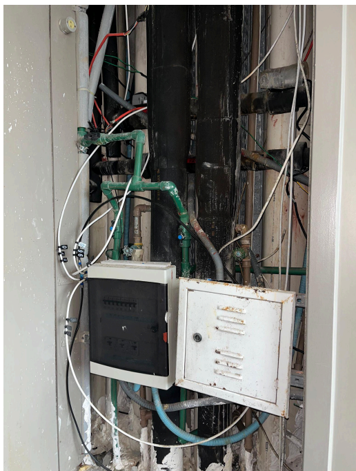
Figura 139 - Agrupamento de vários tipos de cabos
