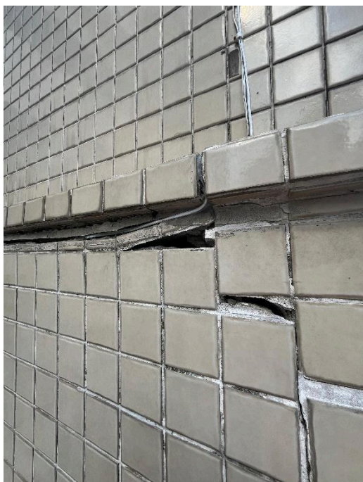
Figura 137 - Pastilhas danificadas devido a junta de movimentação
