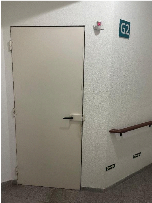
Figura 07 - Porta de acesso a câmara (Garagem G2)
