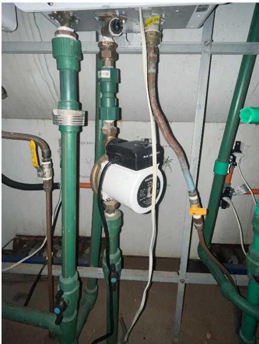
Figura 73 - Bomba aquecedor 3
