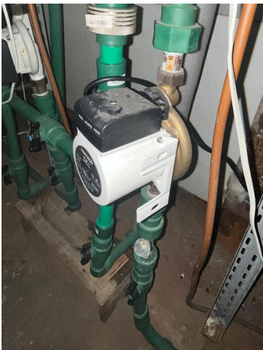
Figura 77 - Bomba aquecedor 4
