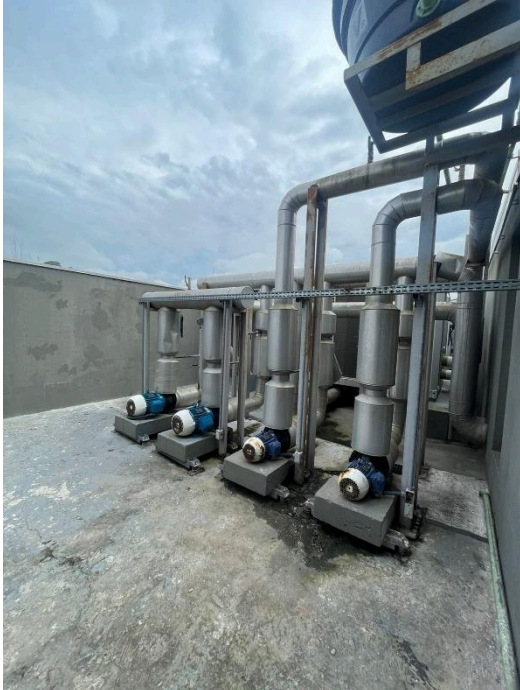
Figura 99 - Motobomba chiller
