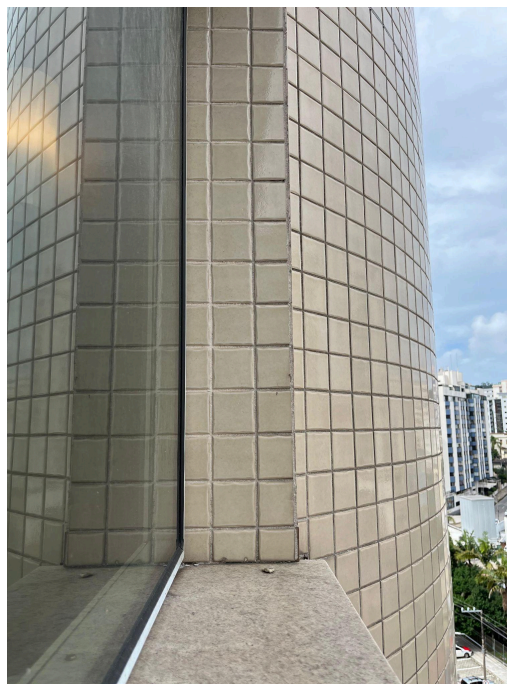
Figura 124 - Vedação de esquadrias das UH's
