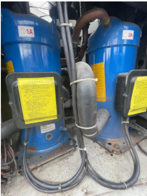
Figura 25 - Compressor chiller
