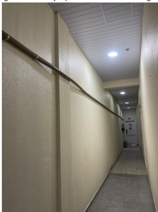
Figura 85 - Tubulação provisória do sistema de esgoto.
