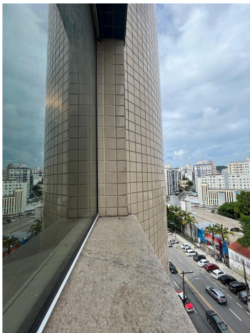
Figura 123 - Vedação de esquadrias das UH's
