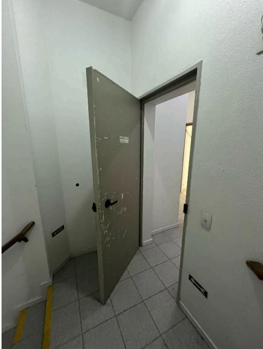
Figura 5 – Porta de acesso a câmara (Garagem G2)
