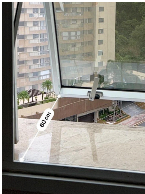
Figura 130 - Abertura esquadrias corredores
