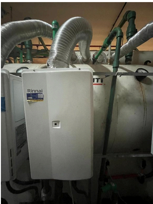
Figura 72 - Painel aquecedor 3
