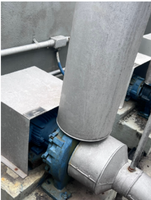
Figura 29 - Troca de isolamento de entrada
