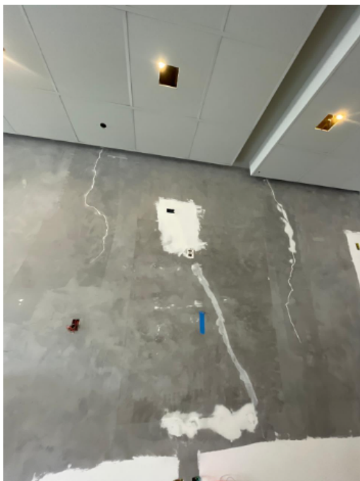
Figura 131 - Área comum em reforma
