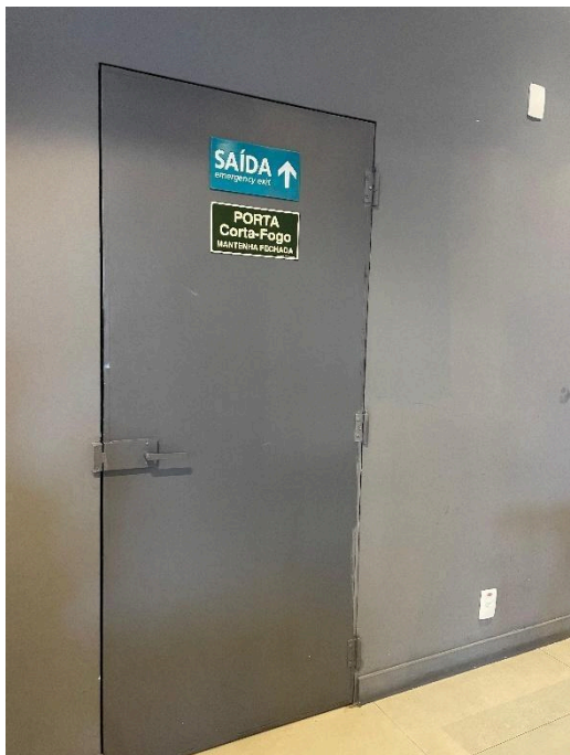
Figura 03 - Porta de acesso a câmara (Térreo)
