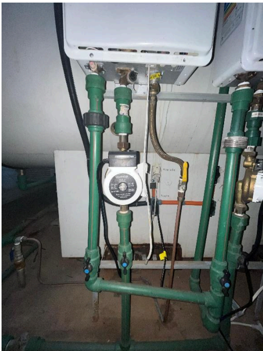
Figura 66 - Bomba aquecedor 1
