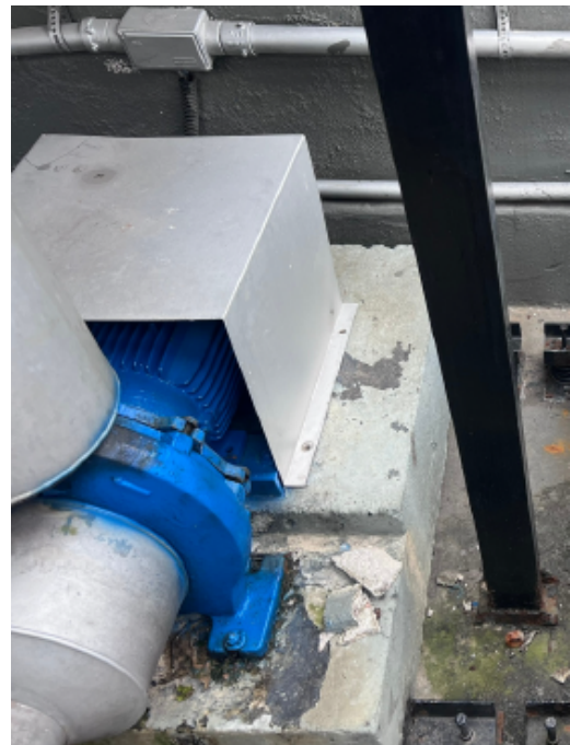
Figura 26 - Motobomba chiller
