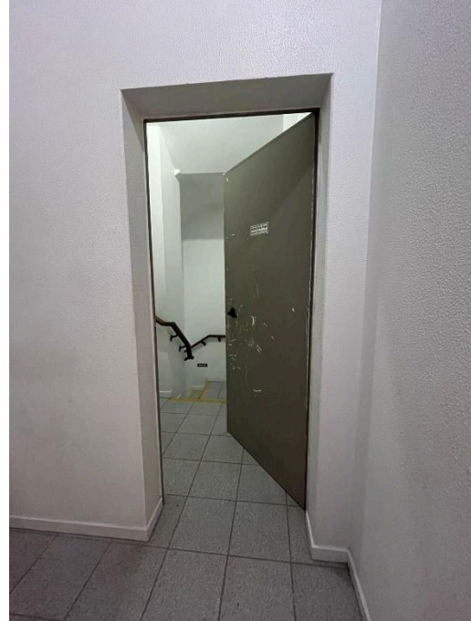
Figura 6 – Porta de acesso a escadaria (Garagem G2)
