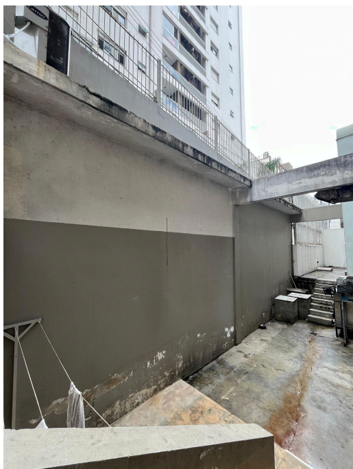
Figura 131 - Muro área dos fundos do hotel
