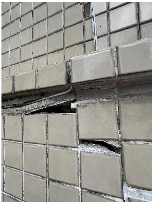
Figura 137 - Pastilhas danificadas devido a junta de movimentação
