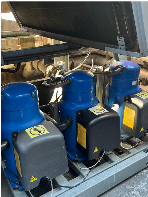
Figura 101 - Compressor chiller
