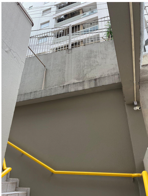
Figura 133 - Muro da escada de acesso funcionários
