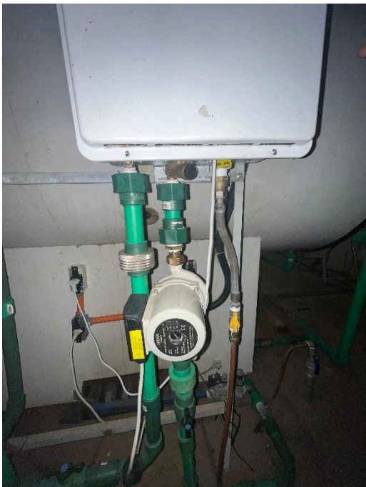
Figura 69 - Bomba aquecedor 2
