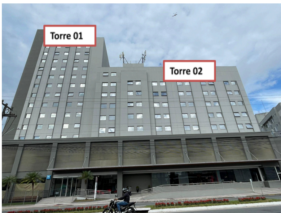
Figura 01 - Identificação de torres
