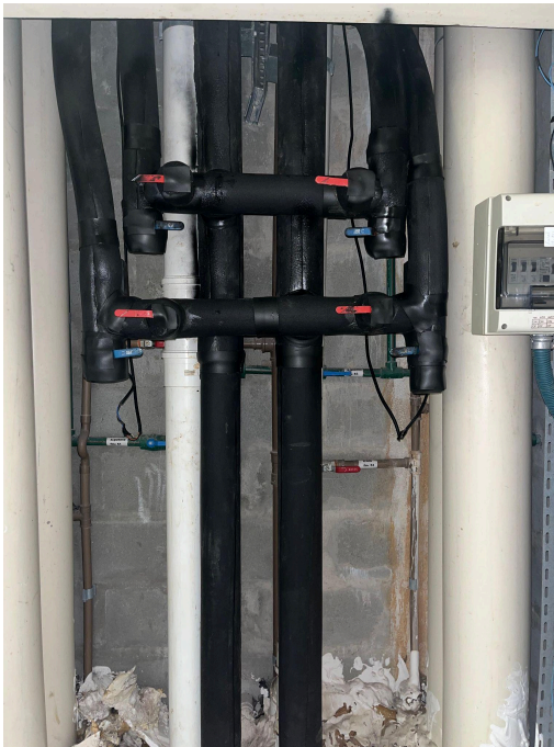
Figura 31 - Novo isolamento de água gelada
