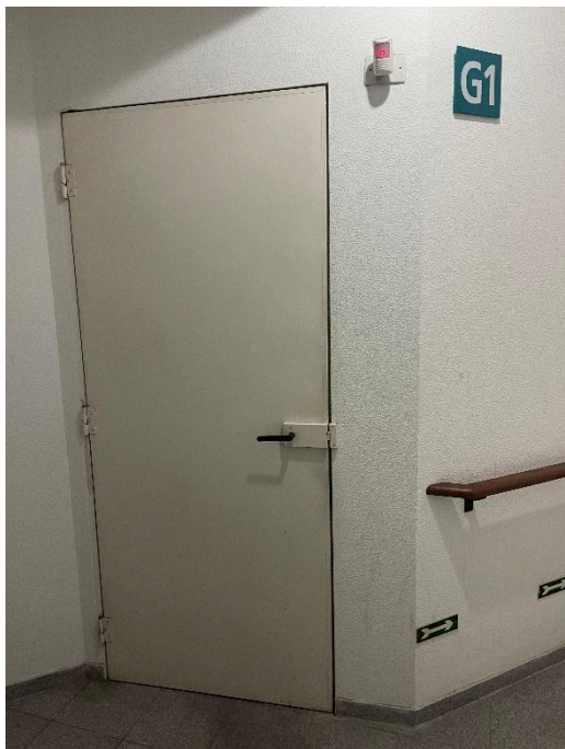
Figura 05 - Porta de acesso a câmara (Garagem G1)
