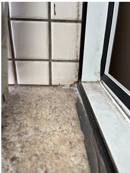
Figura 125 - Vedação de esquadrias das UH's
