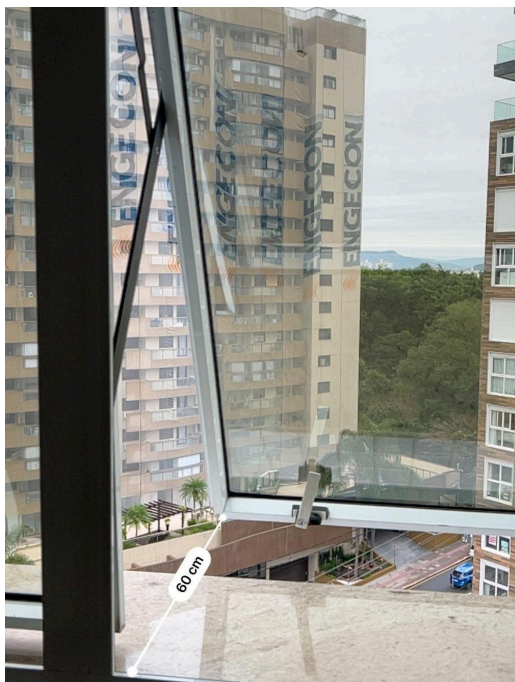
Figura 128 - Abertura esquadrias corredores
