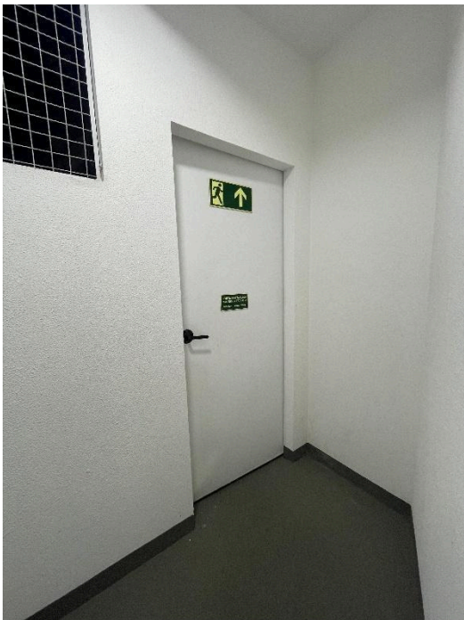
Figura 09 - Porta acesso ao corredor (2° Pav.)
