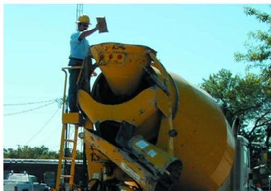
b) Dosagem de aditivo diretamente ao caminhão betoneira
