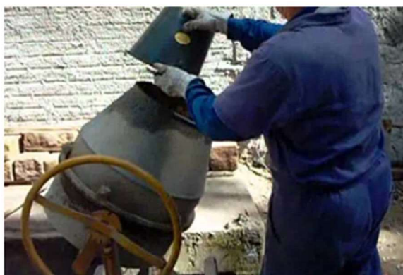
a) Dosagem de aditivo diretamente na betoneira
