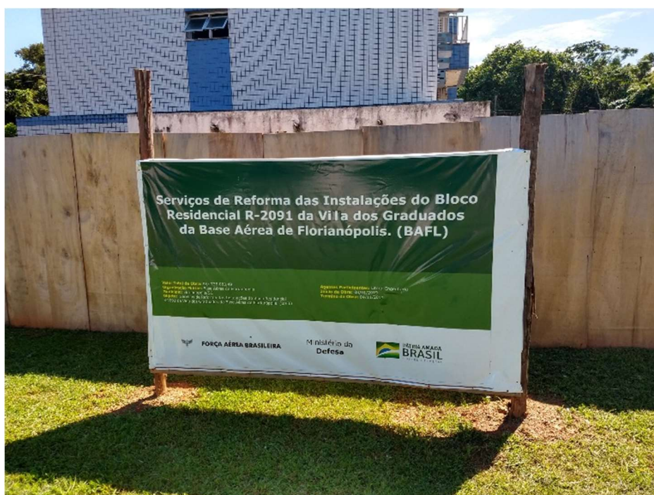
Figura 44 – Cercamento da área de obra com tapume e placa da obra
