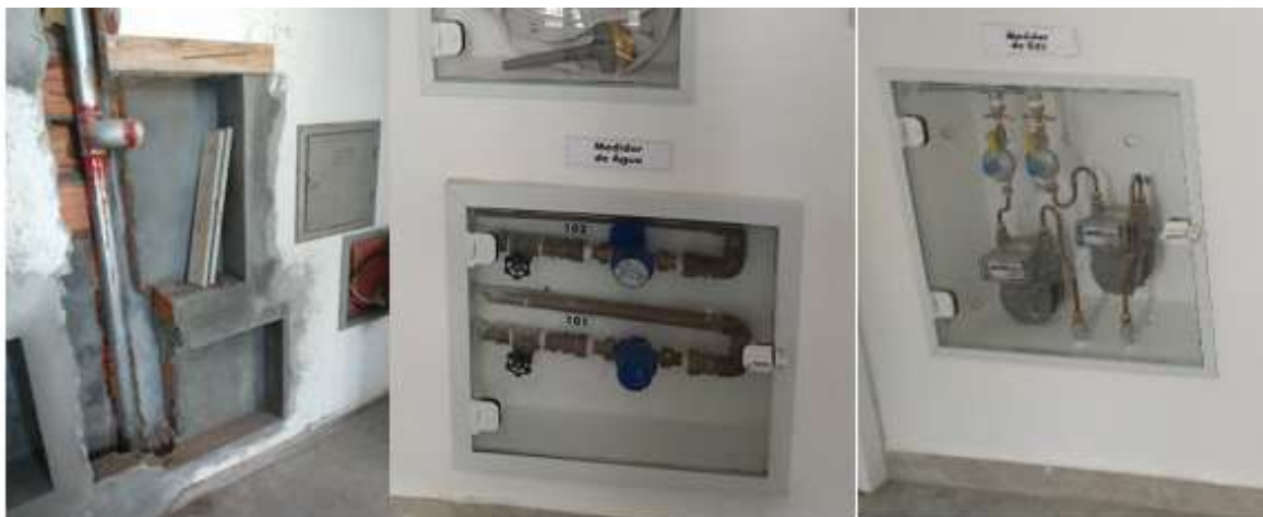
Figura 73 – Execução de mocheta para abrigo dos medidores individuais
