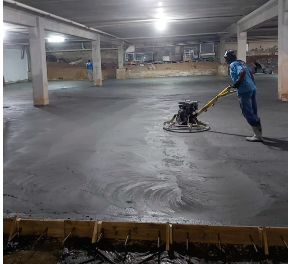
Figura 17 - Execução de acabamento piso industrial.
