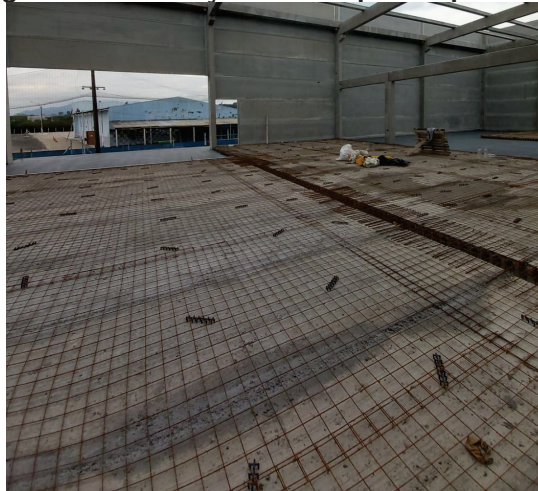
Figura 16 - Instalação malhas para capeamento
