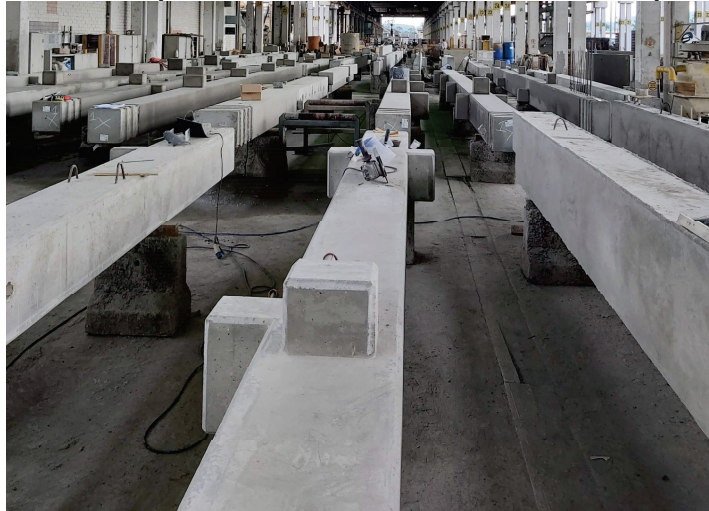
Figura 7 - Pilares pré-fabricados de concreto armado no pátio fabril
