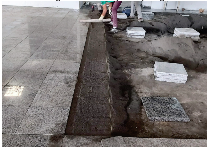
Figura 19 - Instalação de piso granito
