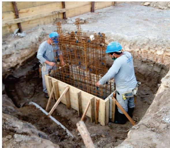
Figura 12 - Armadura bloco de fundação com cálice (cofre) – moldado no local
