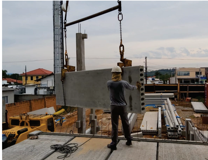
Figura 4 - Placa de fechamento alveolar pré-fabricada de concreto armado
