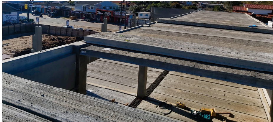
Figura 5 - Lajes alveolares pré-fabricadas de concreto armado
