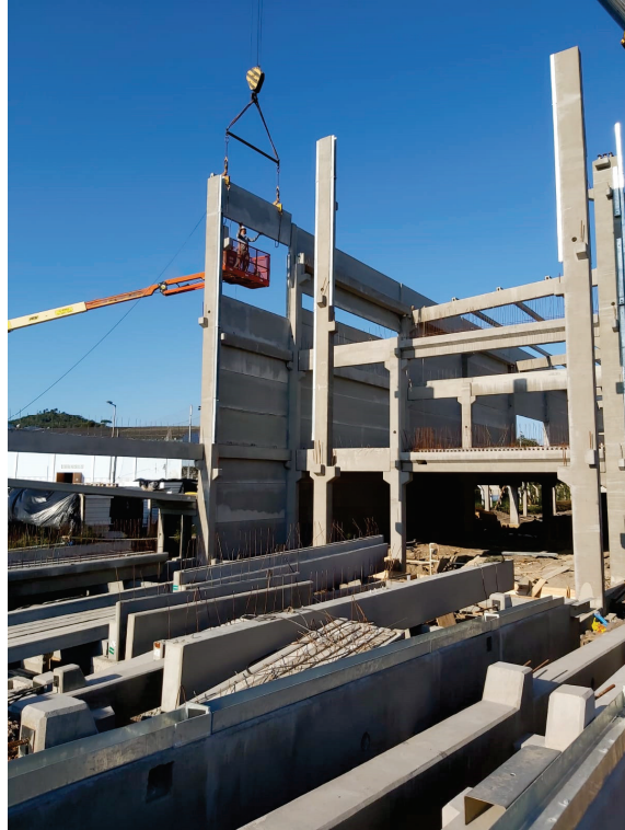
Figura 6 - Pilares e vigas pré-fabricadas de concreto armado
