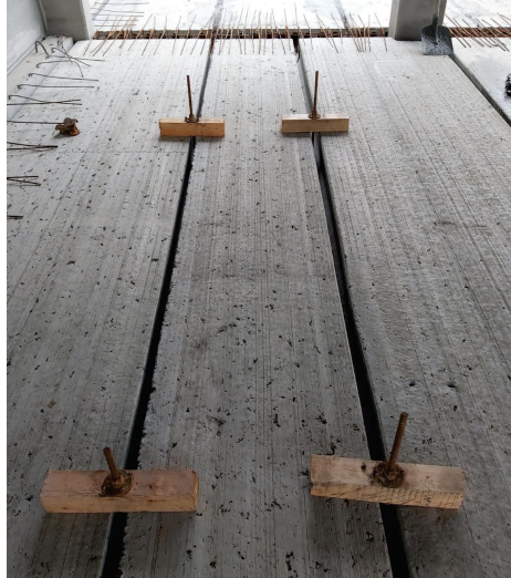
Figura 14 - Equalização de lajes alveolares
