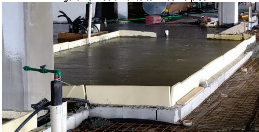
Figura 18 - Isolamento térmico no piso
