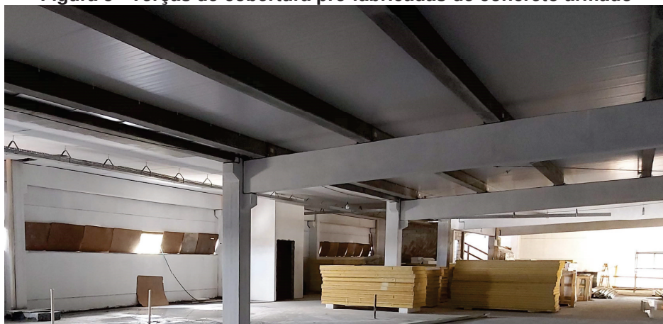
Figura 8 - Terças de cobertura pré-fabricadas de concreto armado
