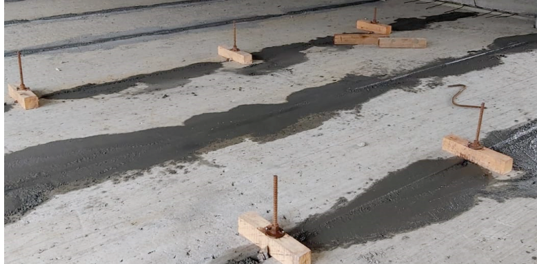
Figura 15 - Chaveteamento (rejuntamento) de lajes alveolares
