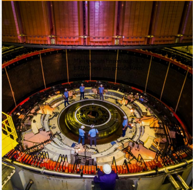
Retirada do estator da Unidade 6 – Usina de Itaipu. Foto: Alexandre Marchetti / Acervo Itaipu Binacional
