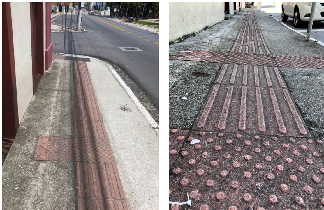
Figura 43 – Piso tátil da calçada da Rua Gaspar Neves
