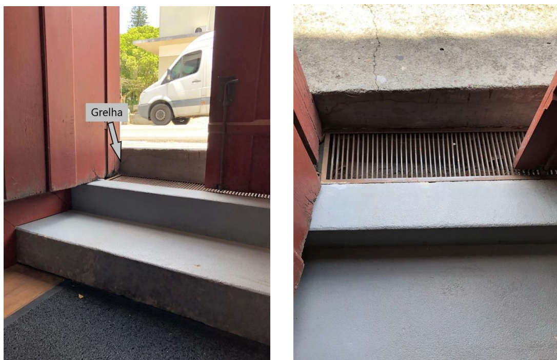
Figura 51 – Grelha na entrada principal (cômodo do Hall)
