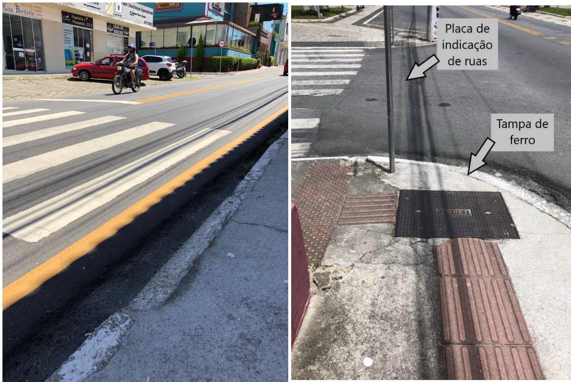
Figura 45 – Local onde deveria haver um rebaixamento da calçada na Rua Gaspar Neves (esq.) e esquina das ruas (dir.)
