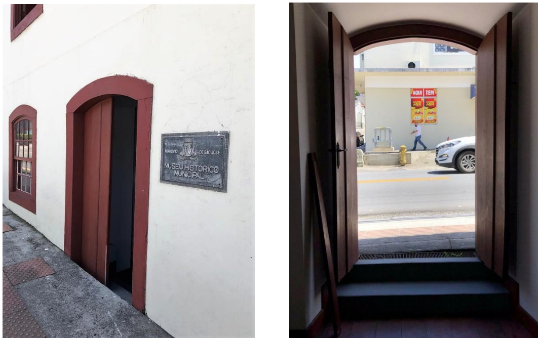
Figura 8 – Porta de entrada principal da edificação – Vista externa (esq.) e interna (dir.)
