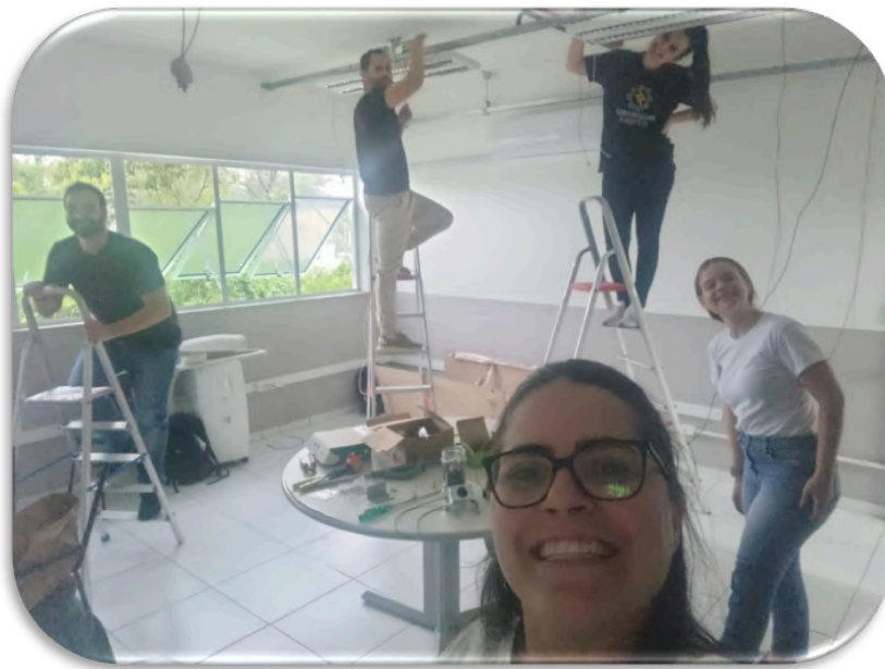
Figura 68 – Montagem das luminárias - Sala AE.
