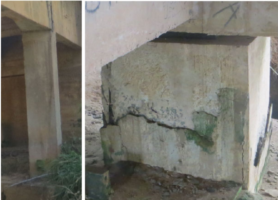
Figura 14 – Pilar Engastado (esquerda) e Pilar Rotulado (direita)
