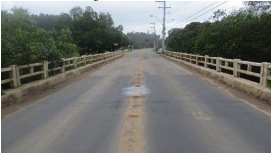
Figura 31 – Vista Geral da Obra
