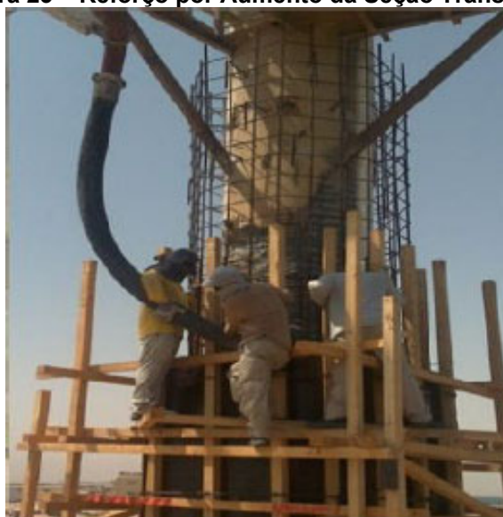
Figura 23 – Reforço por Aumento da Seção Transversal
