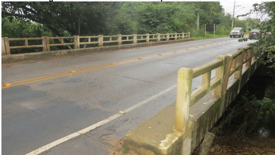
Figura 2 – Ponte Rodoviária – Espírito Santo – ES-010
