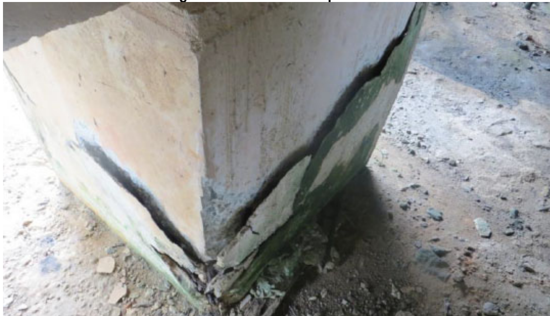
Figura 36 – Concreto Desplacando
