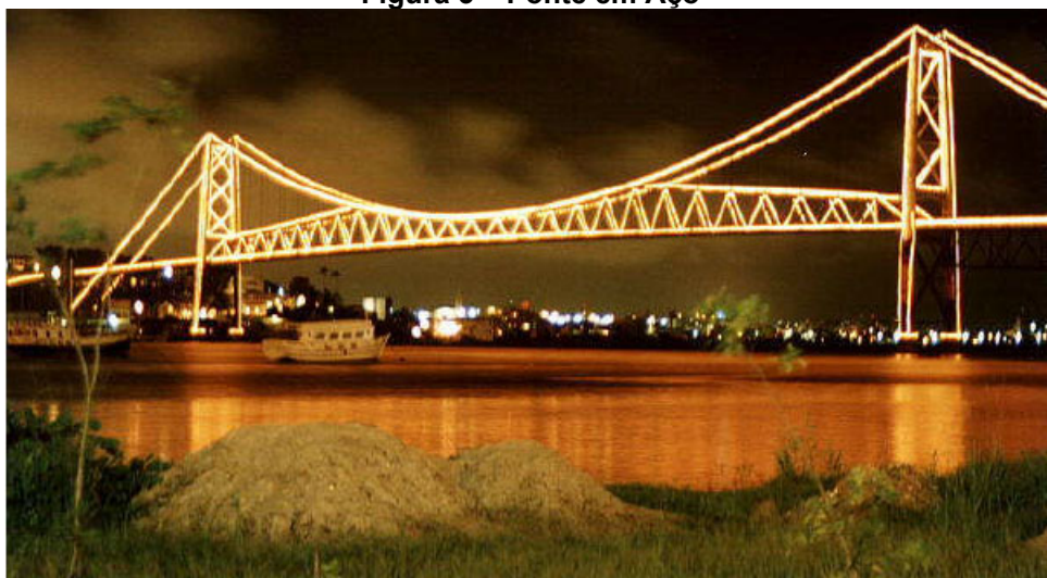
Figura 3 – Ponte em Aço
