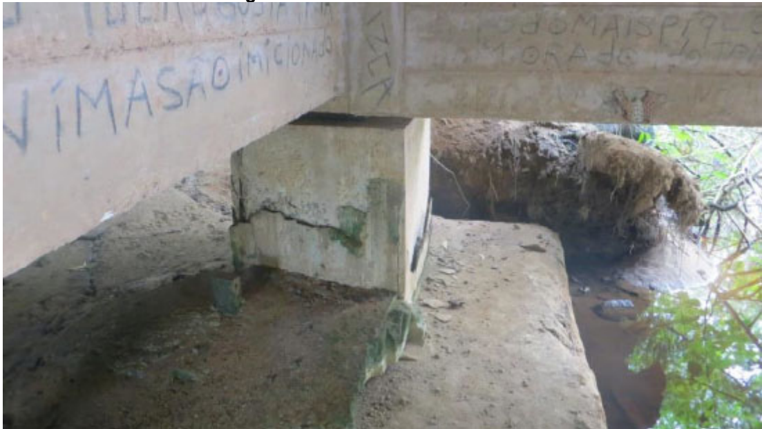
Figura 35 – Vista de um dos Pilares
