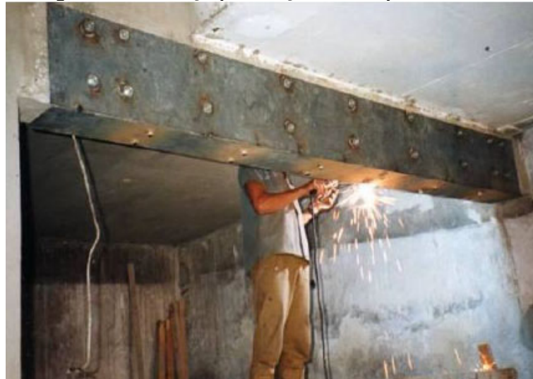
Figura 24 – Reforço por Adição de Chapas Metálicas
