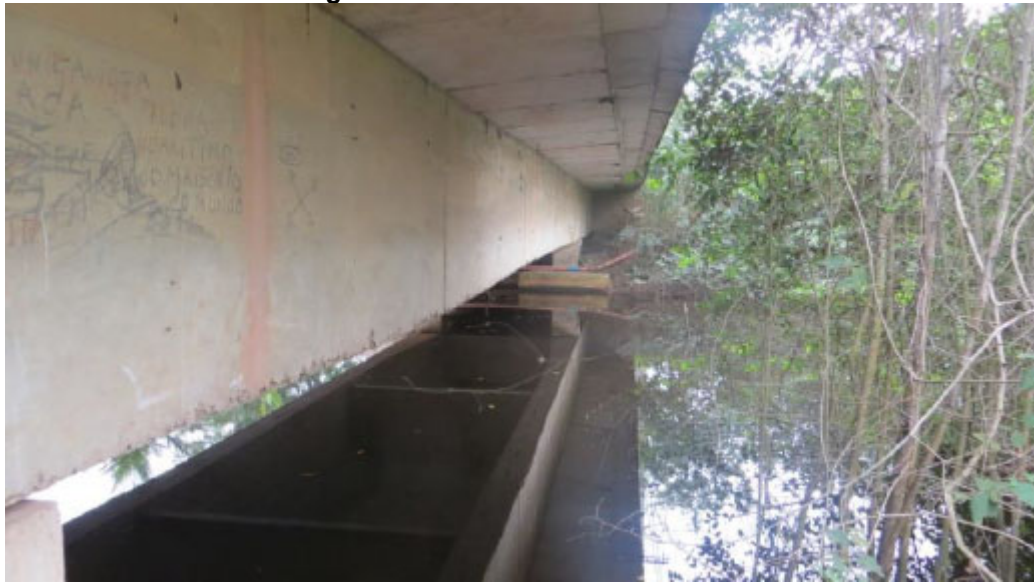
Figura 32 – Detalhe do Vão Central
