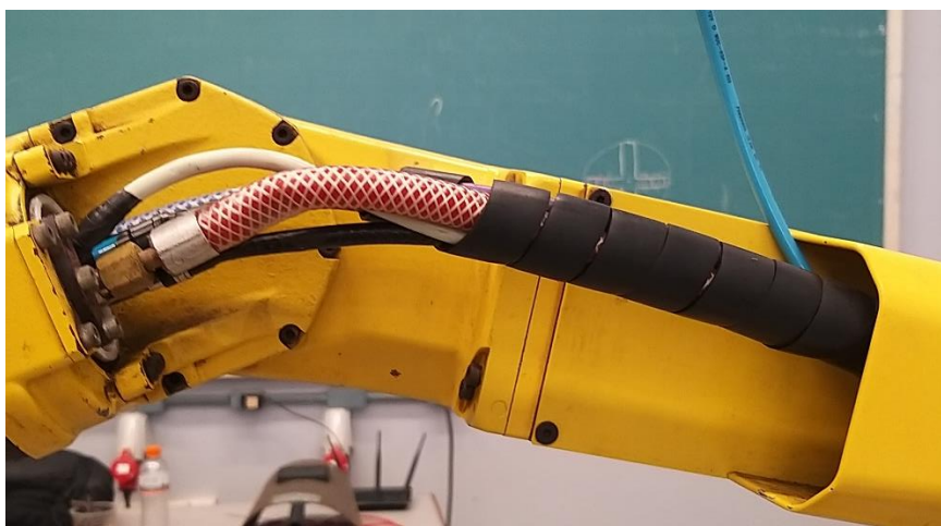
Figura 14 - Cabos reparados e organizados
