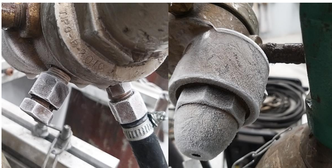
Figura 34 - Formação de gelo na valvula de duplo estágio
