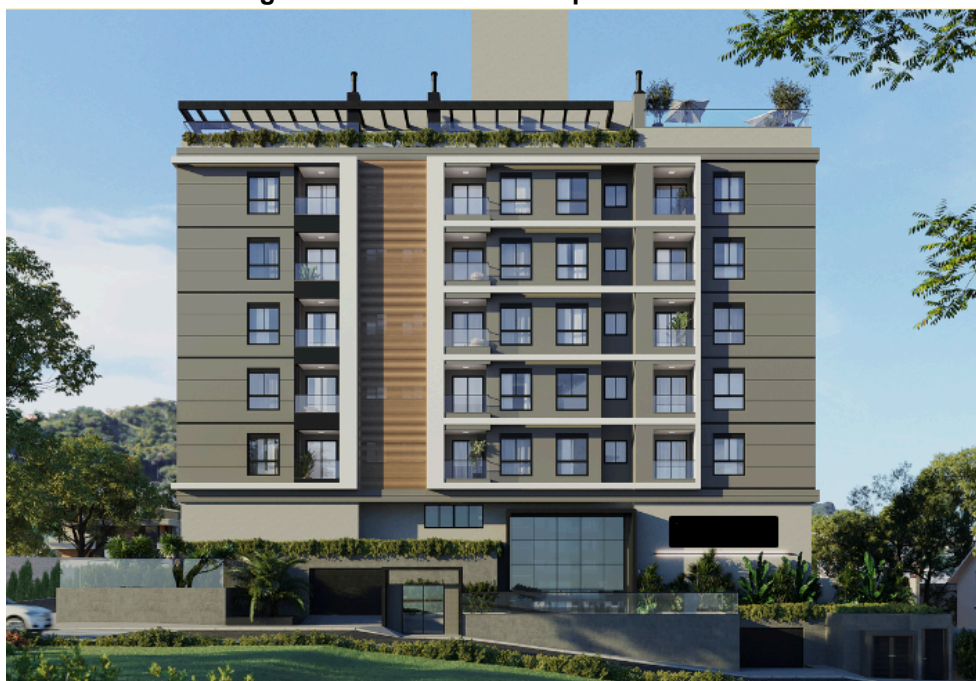
Figura 12 - Fachada do empreendimento.
