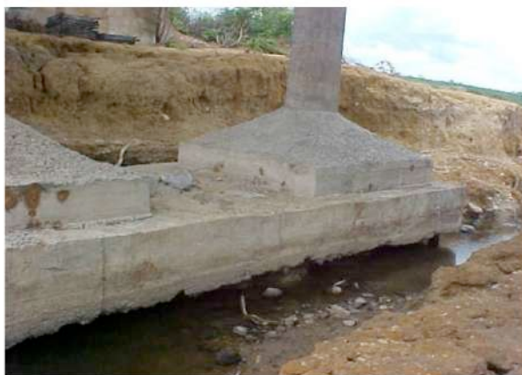
Figura 14 – Sapata de fundação de ponte. Fonte: Vitório (2014).
