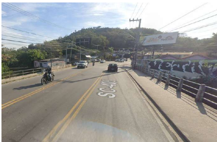
Figura 22 - Vista da ponte sobre o Rio Tavares. Fonte: Adaptada de Google Maps (2023).
