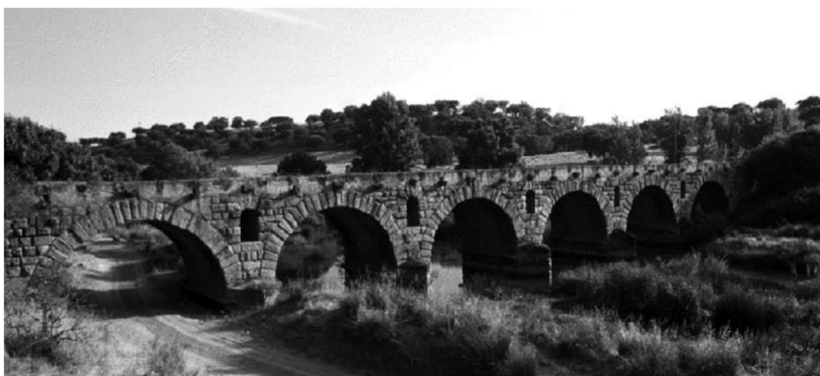
Figura 10 - Ponte romana de Vila Formosa, sobre a ribeira de Seda, em Portugal. Fonte: Mantas (2014).
