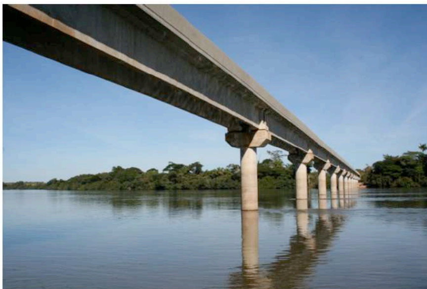
Figura 18 - Ponte sobre o Rio Teles Pires (MT). Fonte: Fernandes e Correia (2017).
