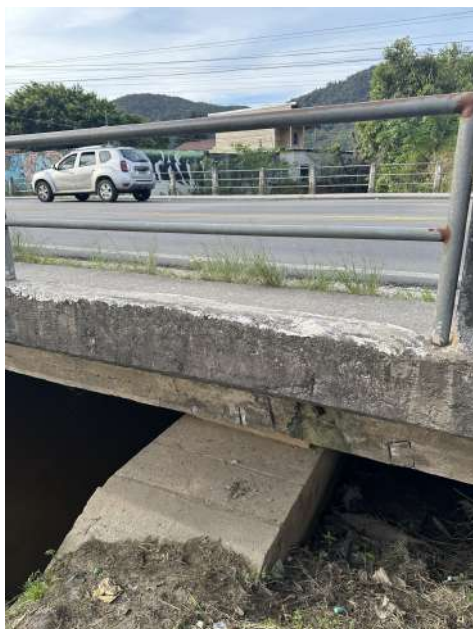
Figura 30 - Corrosão de armaduras do tabuleiro e do guarda corpo na ponte sobre o Rio Tavares.
