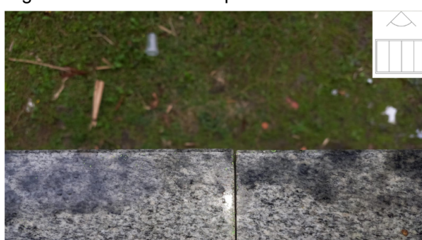
Figura 16: Interface entre peitoris sem selante
