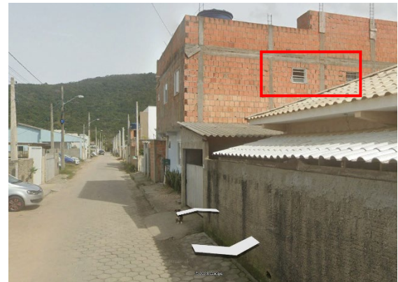
Figura 4 – Janelas edificadas na divisa
