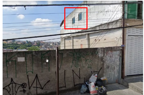
Figura 2 – Janelas edificadas na divisa
