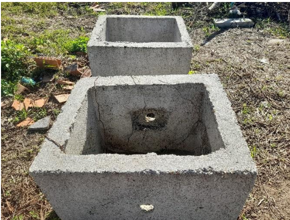
Figura 11: Implantação do sistema de esgoto
