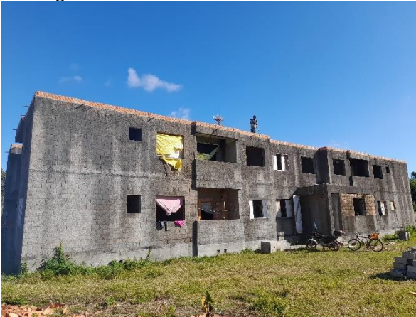
Figura 9: Fachada lateral sem aberturas
