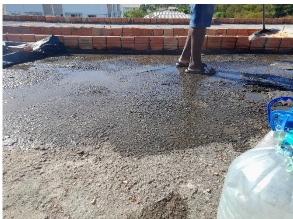
Figura 13: Preparo laje a ser impermeabilizada
