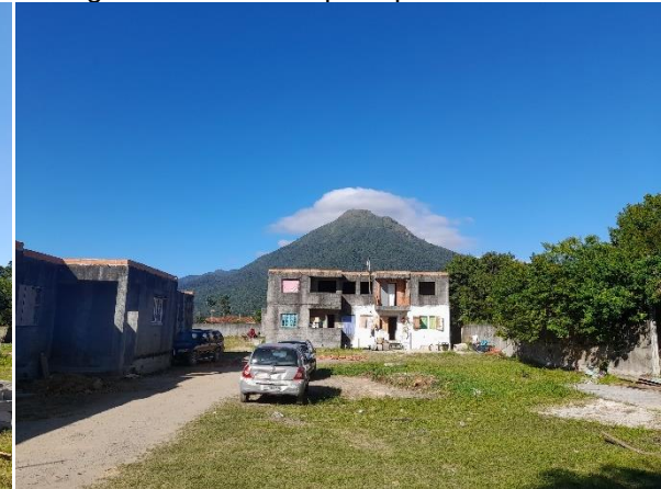
Figura 10: Fachada principal sem aberturas
