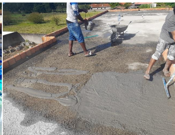
Figura 14: Impermeabilização da laje
