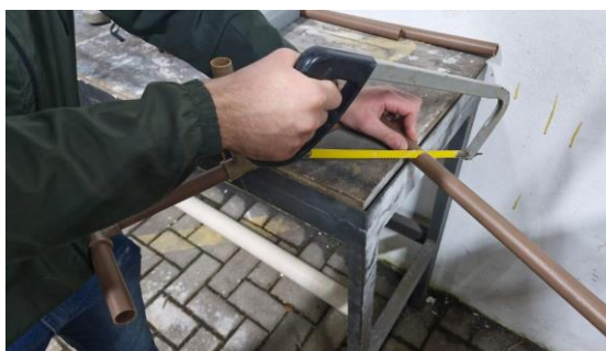
Figura 30 : Corte das tubulações PVC
