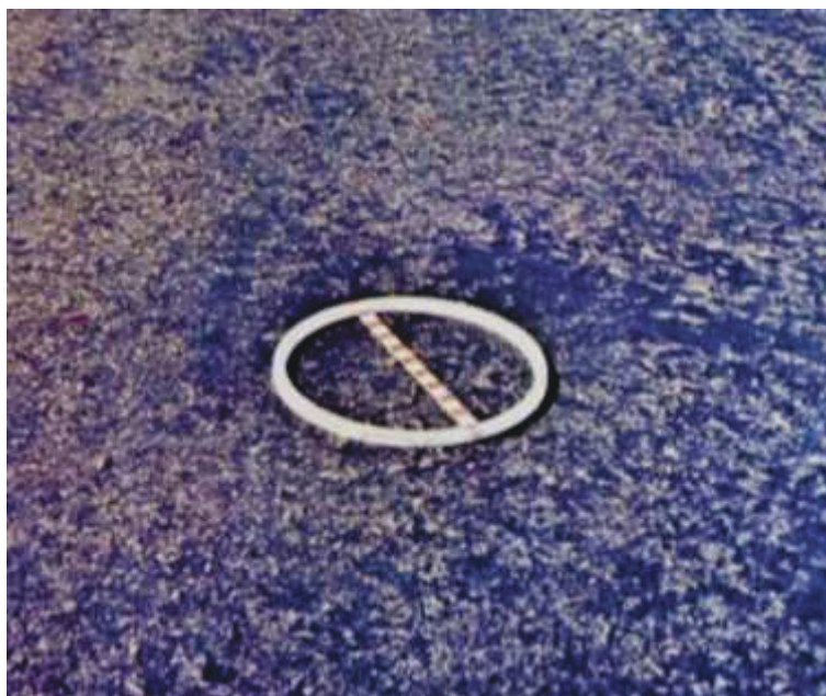
Figura 24 - Exsudação do pavimento
