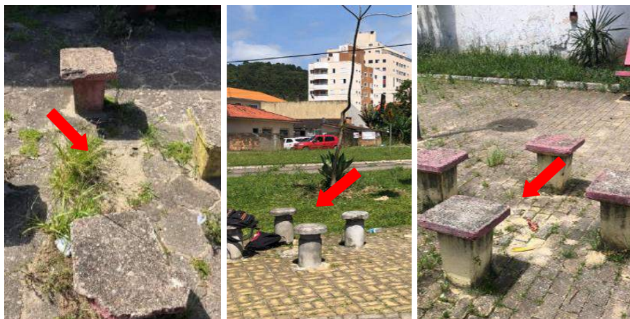
Figura 306 – Mobiliário: ausência de mesas nas Praças 3.05, 13.01 e 13.04 respectivamente
