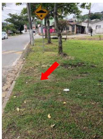
Figura 265 – Ausência de calçada na Praça 10.04
