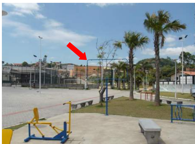
Figura 203 – Placa de instruções danificada na academia da Praça 20.01
