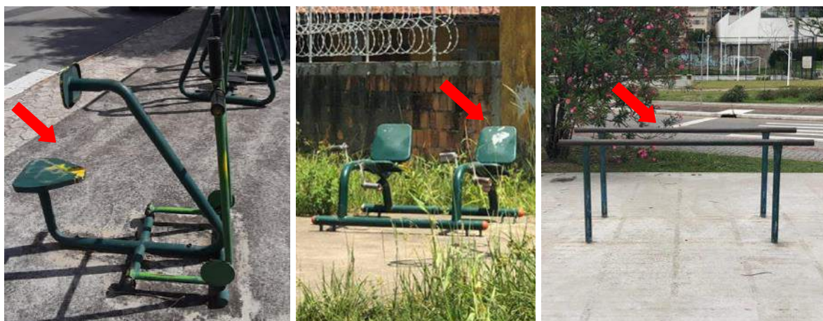
Figura 209 – Equipamento de academia pichado (Praça 2.02) e desgastado por ação de intempéries (Praças 9.04 e 18.02 respectivamente)
