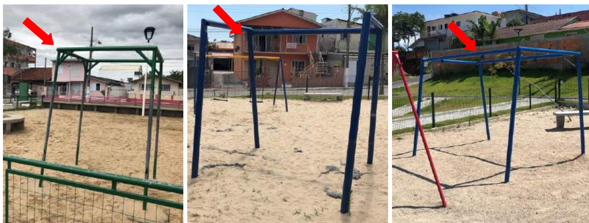
Figura 341 – Parque infantil: balanço acessível danificado nas Praças 10.01, 20.01 e 20.02 respectivamente
