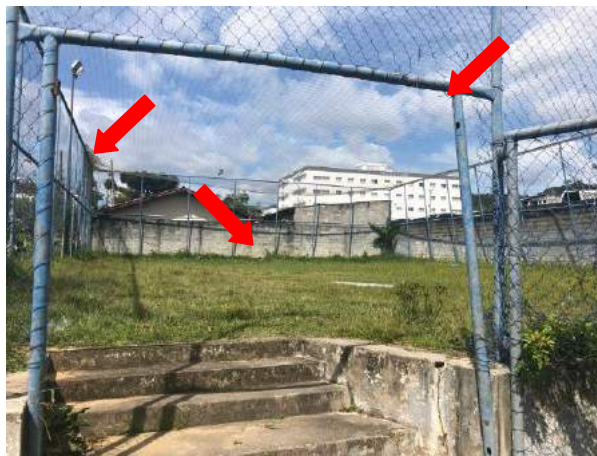
Figura 432 – Campo de futebol de grama da Praça 1.03 – vegetação no alambrado que está danificado e ausência de traves de futebol e portão de acesso
