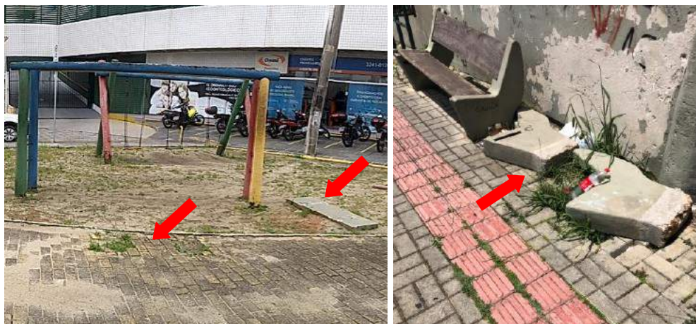
Figura 309 – Mobiliário: mobiliários arrancados nas Praças 12.05 e 20.11 respectivamente
