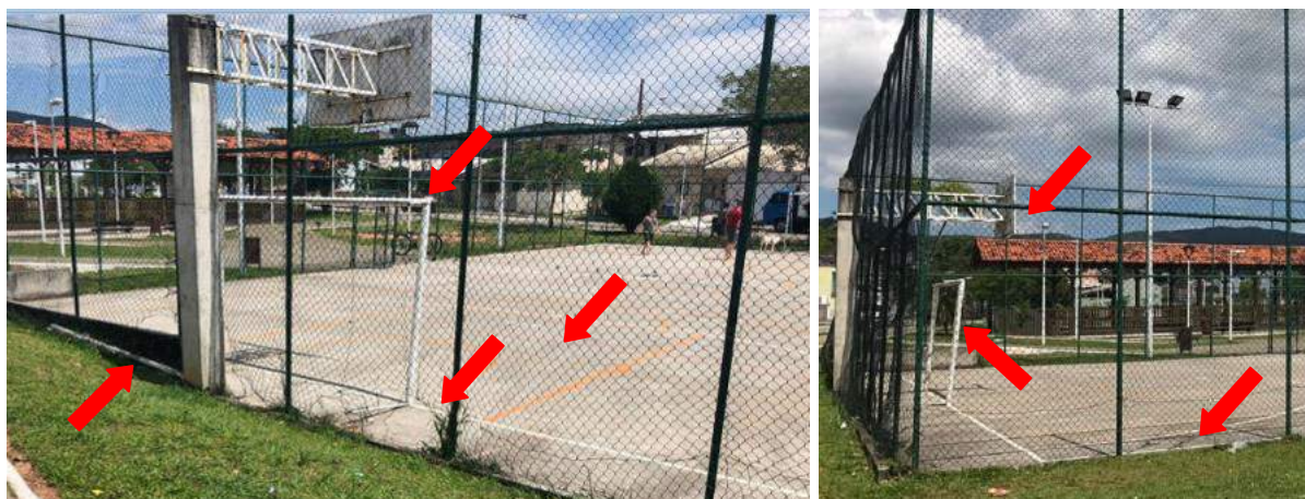
Figura 435 – Quadra de futebol da Praça 9.03 - Traves de futebol sem redes, deslocadas e com elementos soltos; ausência de cestas de basquete; tela do alambrado danificada
