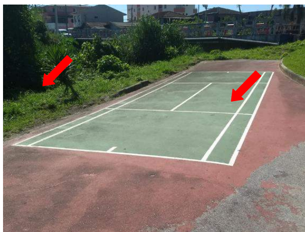
Figura 447 – Quadra de tênis: pintura improvisada no piso; ausência de rede e alambrado na Praça 21.02
