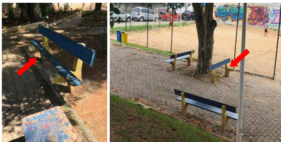
Figura 313 – Mobiliário: bancos sem assentos de madeira na Praça 3.01 e 11.02 respectivamente
