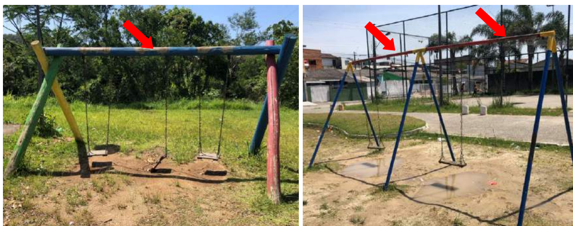
Figura 334 – Parque infantil: balanço danificado nas Praças 20.05 e 20.12 respectivamente
