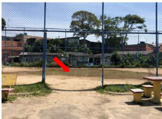
Figura 277 – Acúmulo de água na quadra de esportes da Praça 20.10
