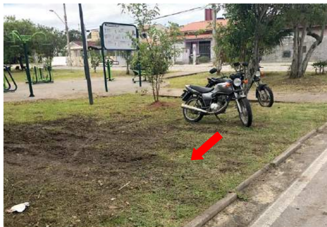
Figura 247 - Ausência de balizador de veículos na Praça 10.04
