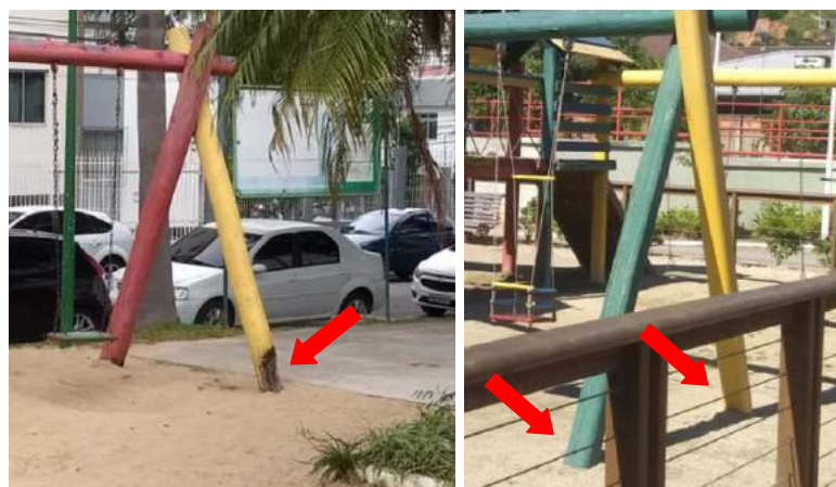
Figura 332 – Parque infantil: equipamento com base de sustentação em fase de decomposição na Praça 12.01 e equipamento que possui fechamento perimetral (Praça 12.01) - protegendo o mesmo da ação de urina de cães
