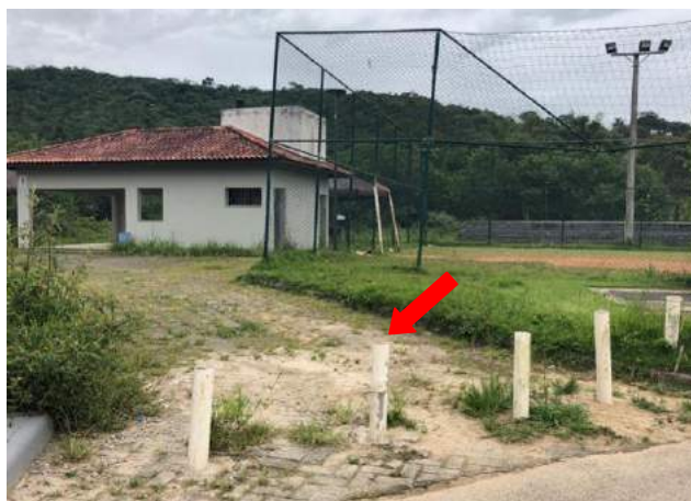
Figura 238 - Situação do balizador de veículos na Praça 17.03
