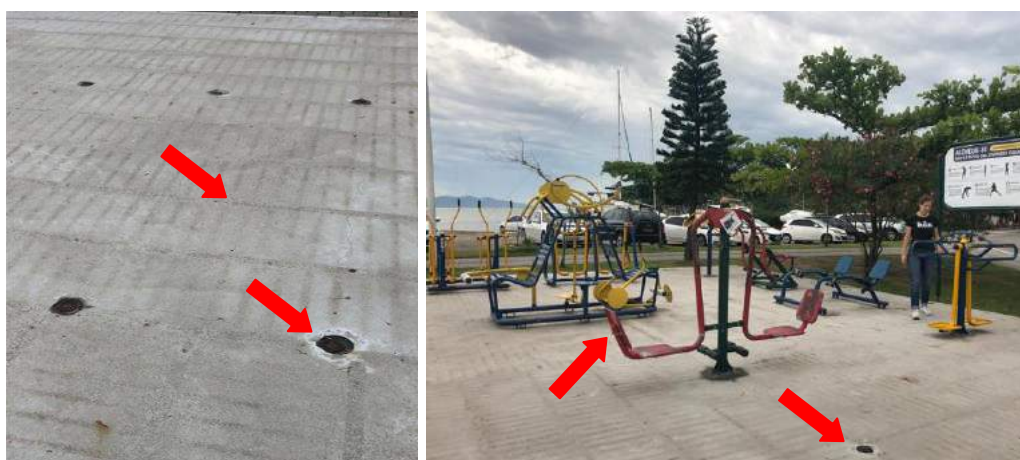
Figura 200 – Ausência de equipamentos e pintura precária na academia na Praça 18.02
