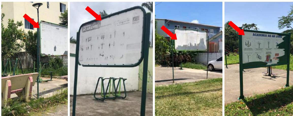
Figura 202 – Academia: placa de instruções danificada nas Praças 13.04, 19.01, 20.03 e 20.05 respectivamente.
