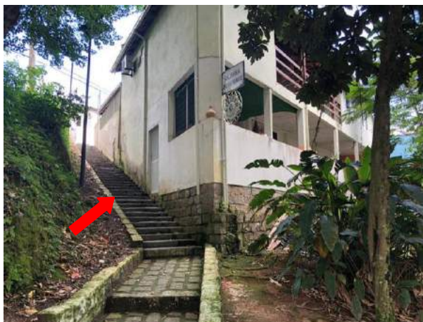
Figura 216 - Acessibilidade prejudicada no acesso à Praça 5.06
