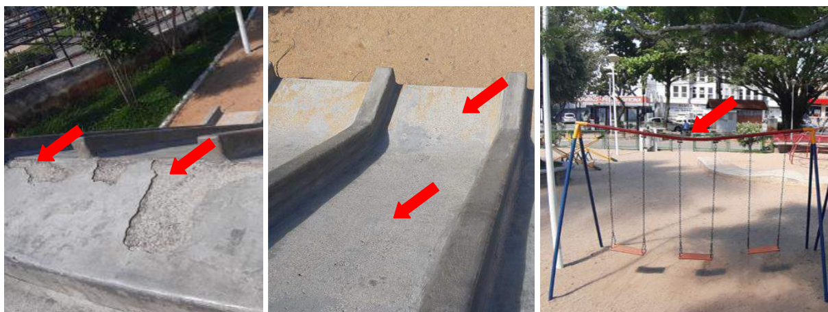
Figura 330 – Parque infantil: piso do escorregador e estrutura de sustentação do balanço danificados na Praça 2.01
