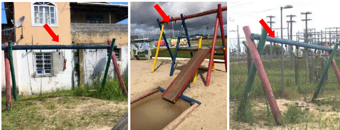
Figura 333 – Parque infantil: balanços com ausência de corrente e/ ou assento nas Praças 3.05 e 12.11 e 19.02 respectivamente
