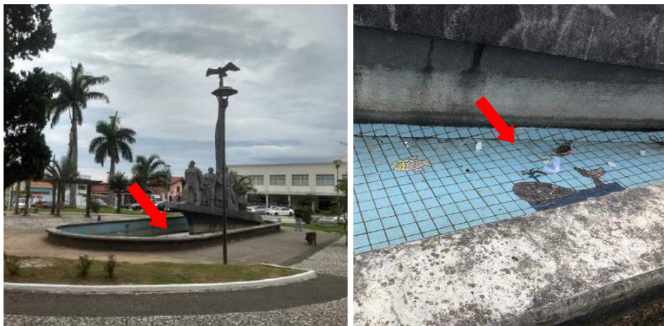
Figura 227 - Acúmulo de lixo na Praça 5.01
