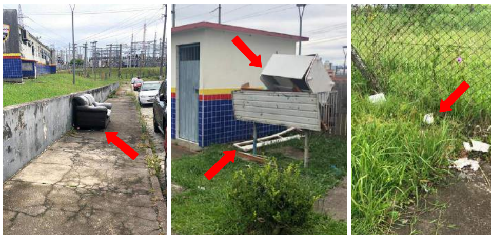
Figura 231 - Acúmulo de lixo na Praça 19.02
