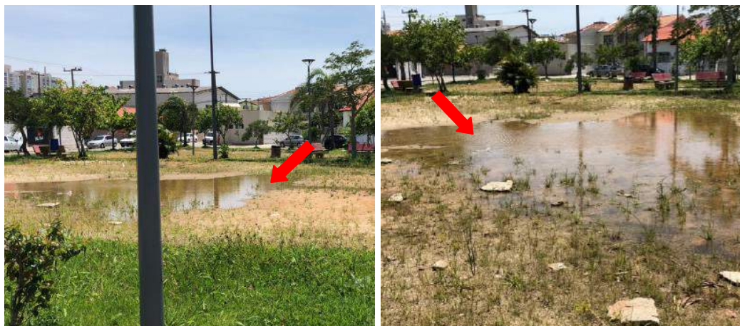
Figura 276 – Acúmulo de água na Praça 20.08
