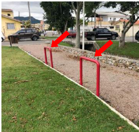
Figura 245 - Balizador de veículos na Praça 10.01
