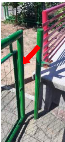
Figura 222 – Fecho quebrado no portão de acesso ao parque infantil danificado na Praça 2.01
