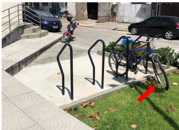
Figura 410 – Bicicletário: posição inadequada na Praça 20.04
