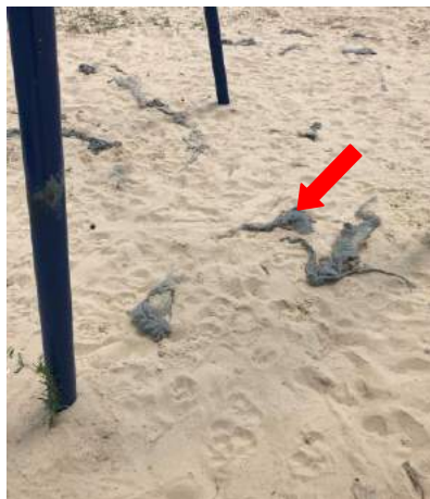
Figura 256 – Situação da caixa de areia no parque infantil da Praça 20.01
