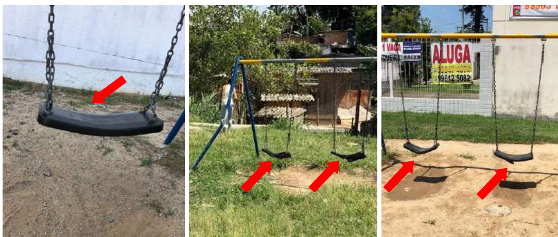
Figura 338 – Parque infantil: banco do balanço danificado nas Praças 3.03, 20.10, 20.15 respectivamente
