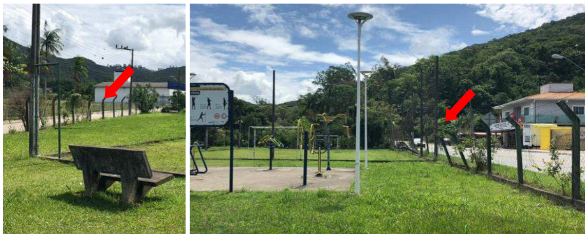
Figura 223 – Fechamento perimetral na Praça 6.01
