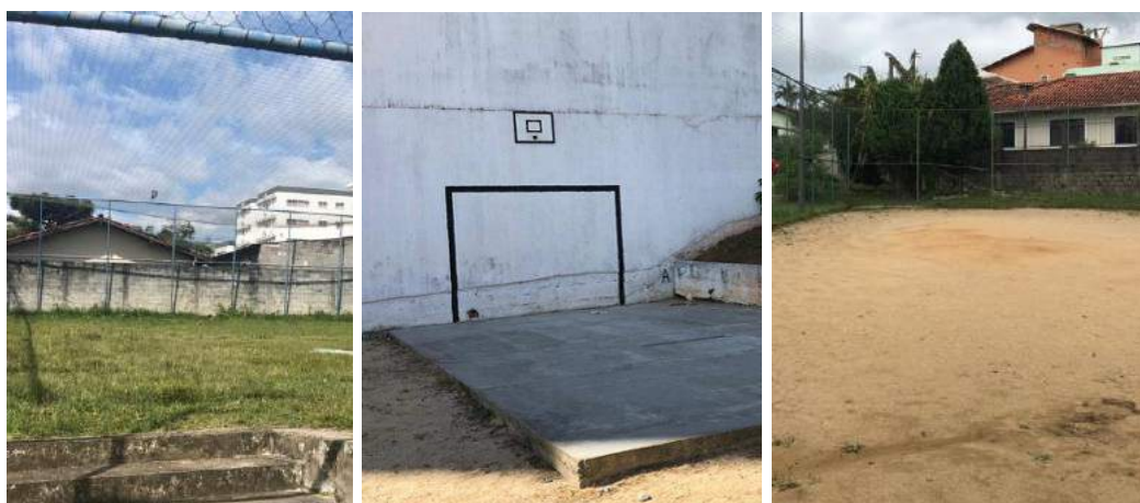
Figura 394 – Quadra de esportes: ausência ou improvisação de trave de futebol - Praças 1.03, 3.03 e 8.03 respectivamente
