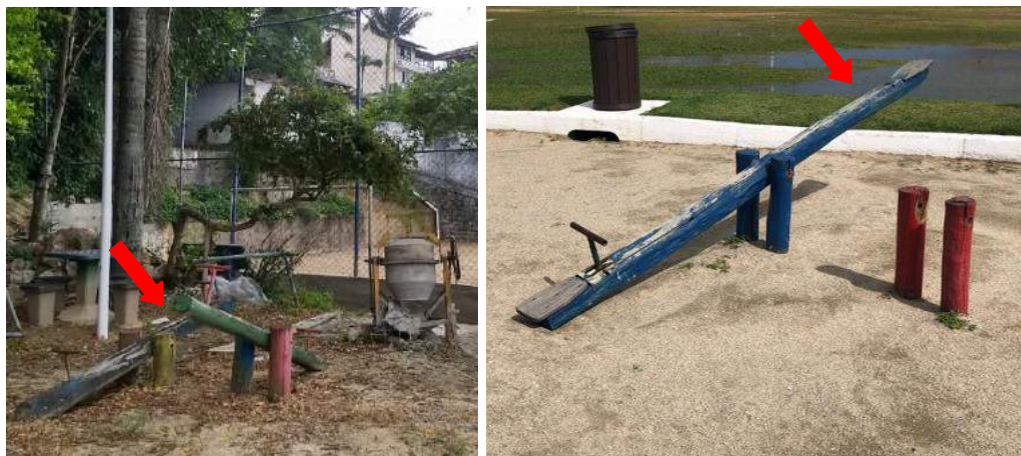
Figura 336 – Parque infantil: equipamentos com estruturas em estado precário nas Praças 5.04 e 12.11 respectivamente
