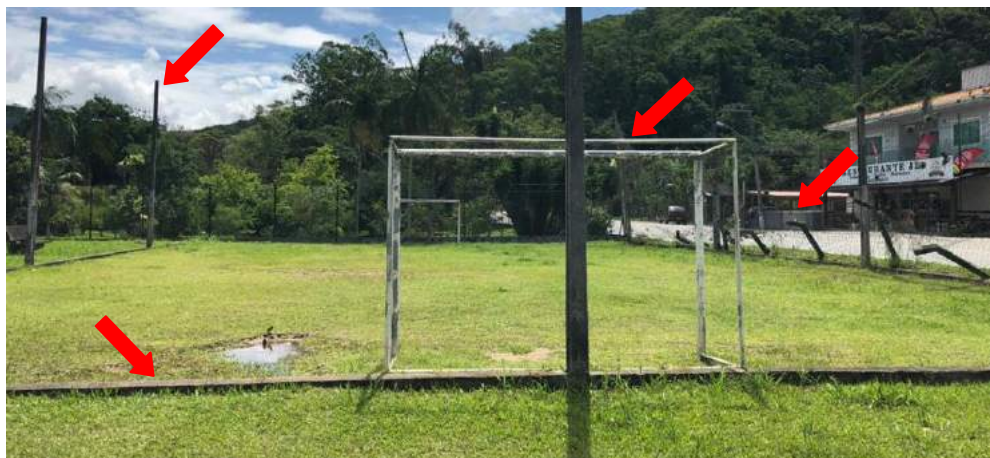
Figura 428 – Campo de futebol: traves sem a rede, ausência de rede protetora e presença de mourões deslocados na Praça 6.01
