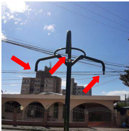
Figura 204 – Equipamento de academia danificado na Praça 2.02
