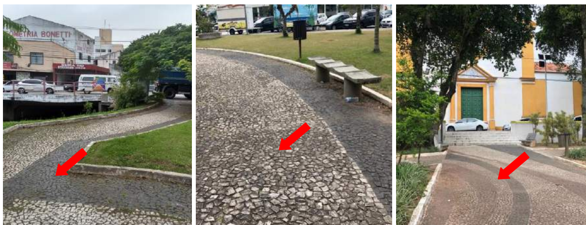
Figura 351 – Passeio interno: pedras petit-pavé com excesso de material orgânico na superfície (Praças 4.01, 5.01 e 5.02 respectivamente)
