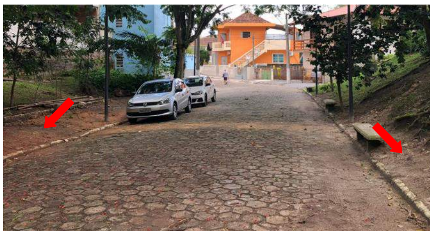
Figura 263 – Ausência de calçada nos dois lados da via situada na Praça 5.06
