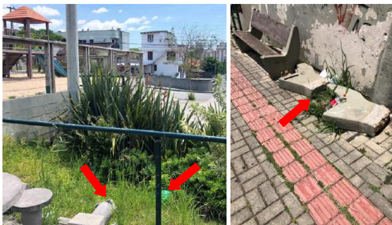
Figura 229 - Acúmulo de lixo na Praça 20.11
