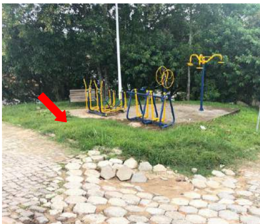
Figura 267 – Ausência de calçada na Praça 17.04
