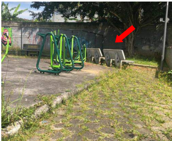
Figura 305 – Mobiliário: bancos com posição inadequada na Praça 1.03
