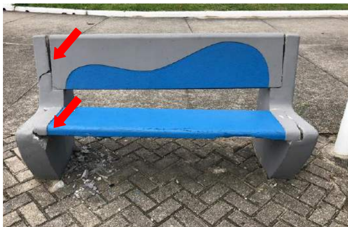
Figura 314 – Mobiliário: banco danificado na Praça 4.02
