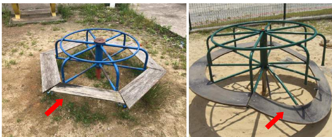
Figura 344 – Parque infantil: gira-gira danificado nas Praças 19.01 e 20.01 respectivamente
