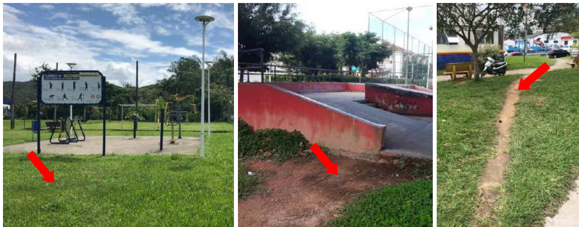
Figura 353 – Passeio interno: ausência próximo à estruturas (Praça 6.01, 13.02 e 19.02 respectivamente)
