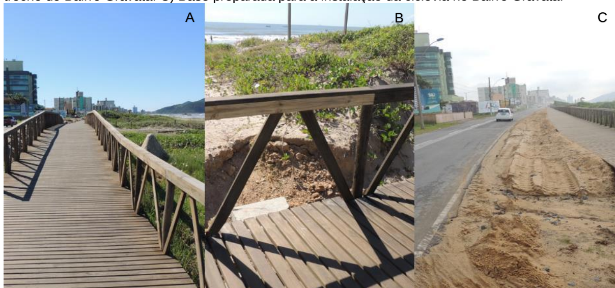
FIGURA 10 – Deck instalado na orla no ano de 2016. A) Ponte sobre o Ribeirão das Pedras. B) Em trecho do Bairro Gravatá. C) Base preparada para a instalação da ciclovia no Bairro Gravatá.
