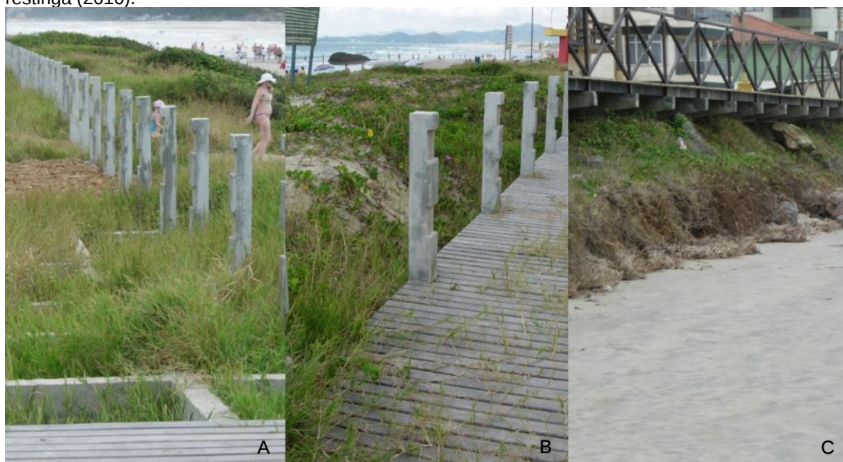
FIGURA 8 – A) Suspensão da instalação das estruturas de concreto (2009). B) Estrutura mista de concreto e madeira (2009). C) Estrutura mista de concreto e madeira sobre enrocamento e faixa de restinga (2010).
