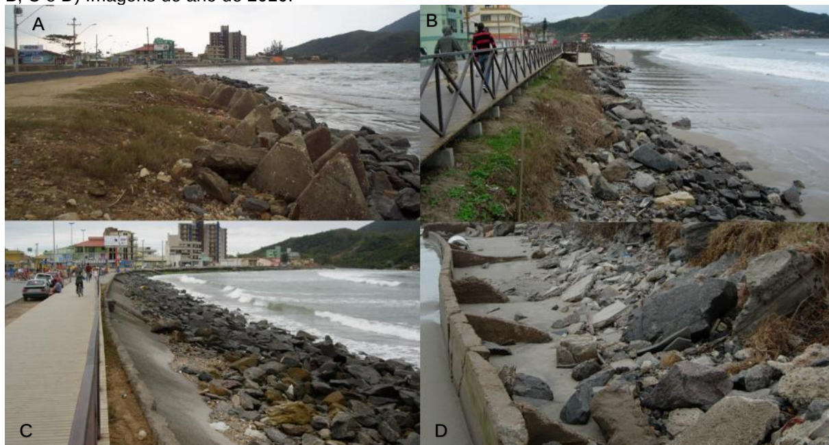
FIGURA 7 – Enrocamento realizado na Praia do Gravatá a partir de 2003. A) Imagem do ano de 2004. B, C e D) Imagens do ano de 2010.
