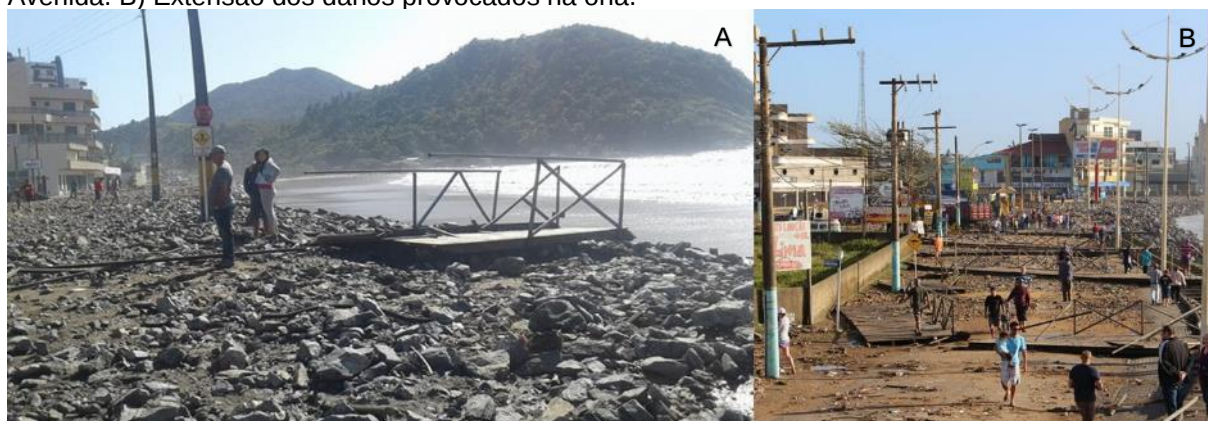
FIGURA 11 – Danos provocados na orla do Gravatá na ressaca ocorrida em novembro de 2016. A) Estrutura do deck de madeira completamente destruída e material do enrocamento arremetido para a Avenida. B) Extensão dos danos provocados na orla.
