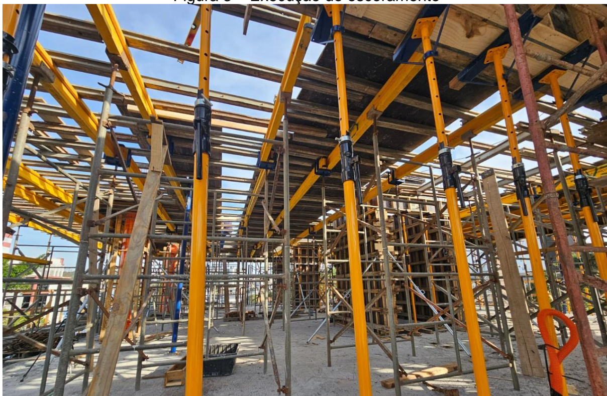
Figura 3 – Execução do escoramento
